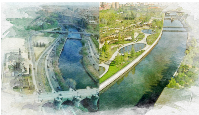
IMG06. Antes y después del proyecto Madrid Río. Fuente: Elaboración propia.
