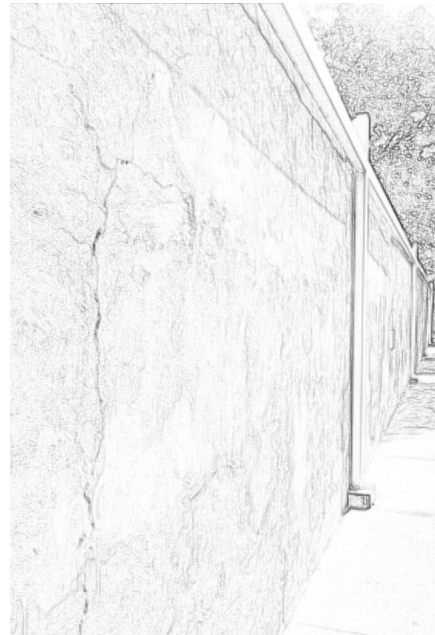
IMG80. Comparación de fachadas con ritmo vertical y elementos horizontales. Fuente: Elaboración propia.
