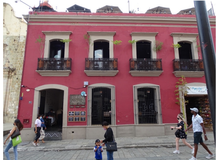
Inmueble en la actualidad. Los bares se encuentran en los dos niveles del inmueble y el nivel de azotea se habilitó para establecer un restaurante, mayo de 2022. Fuente: elaboración propia.
