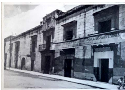
Fachada del MACO 1979. Fuente: Fundación Bustamante Vasconcelos. Tomada de Giraldo (2021).
