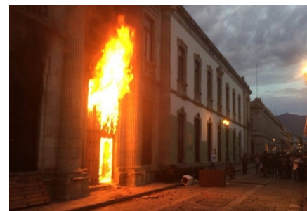
Incendio de la puerta oriente que mira hacia el corredor turístico, 2016. Fuente: https://www.sdpnoticias.com/local/oaxaca/facultad-derecho-prenden-puerta-fuego.html
