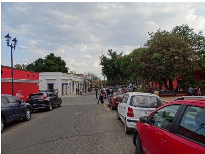
Imagen 69. Pavimento nuevo en banquetas y arrollo vehicular termina en la zona de transición
