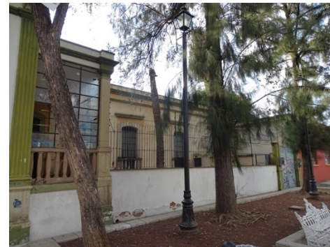
Inmueble desocupado, mayo de 2022. Fuente: elaboración propia.
