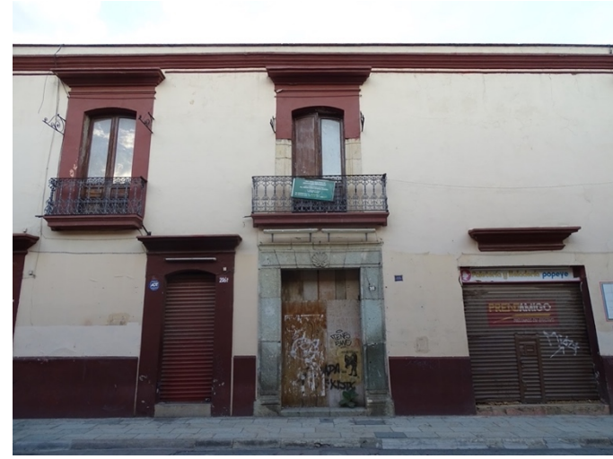
Inmueble desocupado, mayo de 2022. Fuente: elaboración propia.
