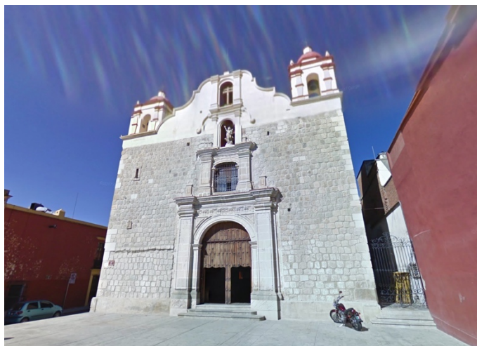
Imagen 66. Remozamiento de la fachada del templo de la Sangre de Cristo
