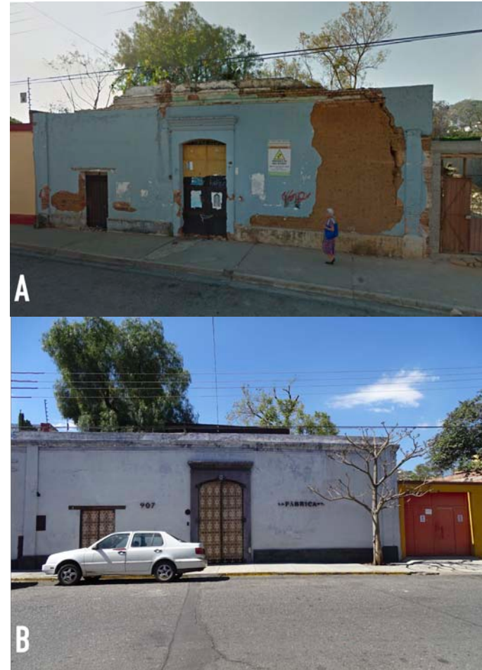
Fachada del inmueble en 2014 (A) que ocupa actualmente el salón de eventos “La Fábrica” (B). Antiguamente fue un inmueble habitacional que estuvo en desuso y abandonado por varios años. Fuente: imagen A tomada de Google Street View, imagen B elaboración propia, 2022.
