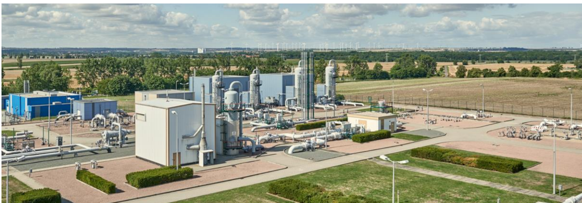
Figura 55. Instalaciones de Bernburg, Alemania (GmbH, 2022).
