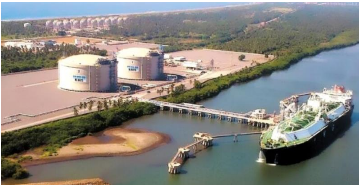
Figura 37. Tanques de almacenamiento de GNL (Economista, 2021).
