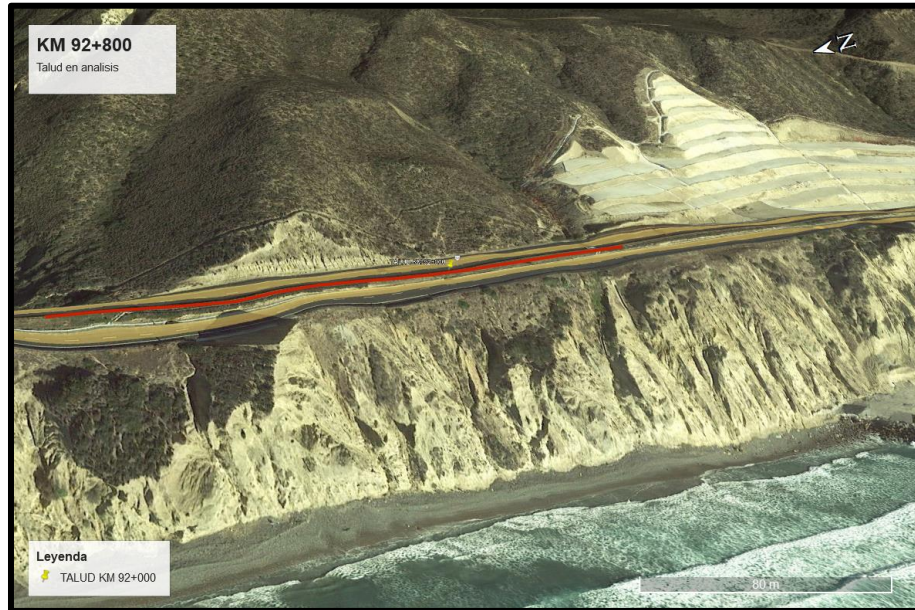
Figura 2. Vista general de talud KM 92+800 en estudio.
