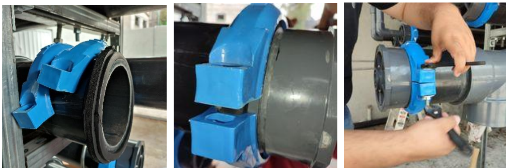
Figura 6. Secuencia de instalación de las bridas.
