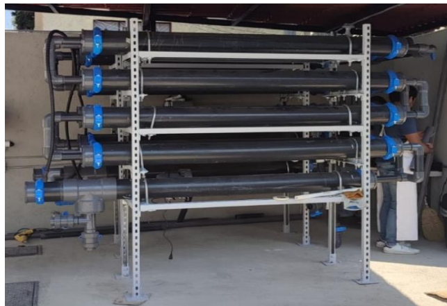
Figura 9 Reactor biológico tubular terminado.
