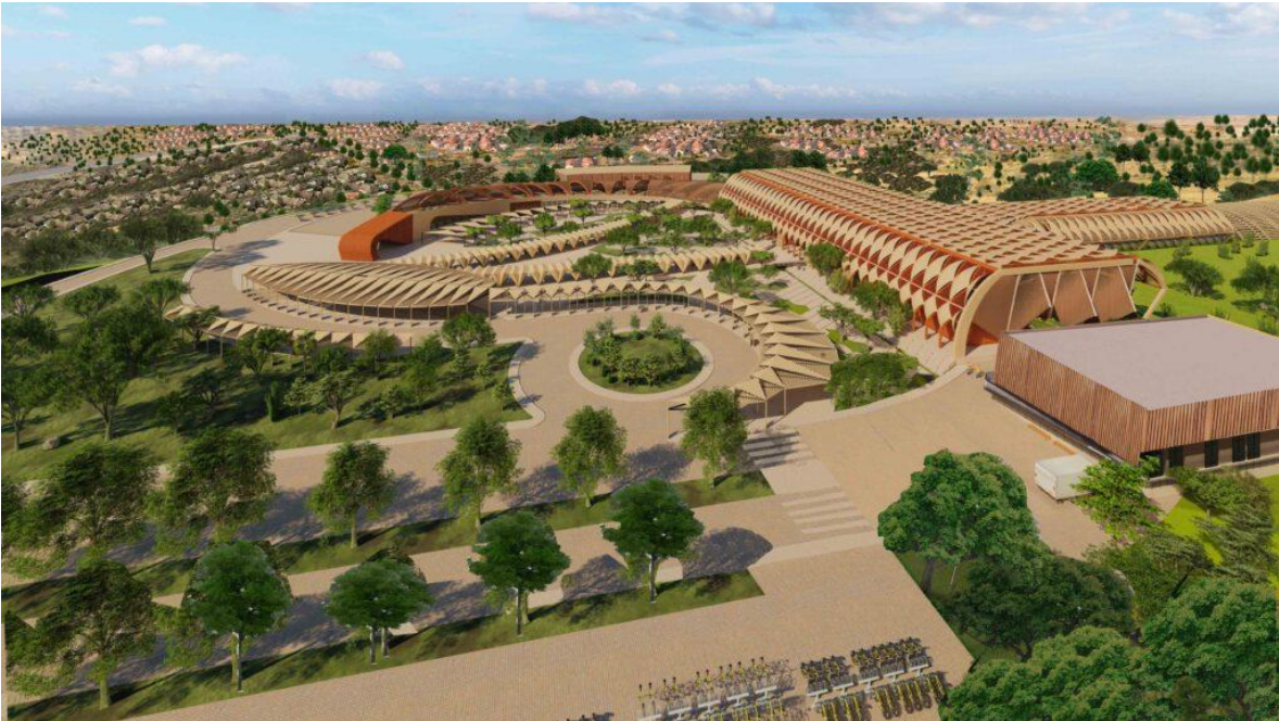
Imagen 35.- Estacion Chichén Itzá del Tren Maya, vista aérea (FONATUR, 2019).
