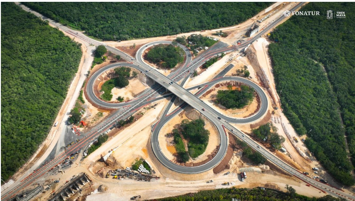
Imagen 76- Obras de infraestructura complementarias al Tren Maya.- (Fuente: FONATUR; 2022)
