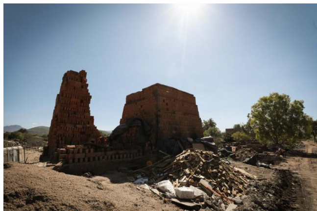
Imagen 8. Uno de los hornos de la ladrillera. Fuente: (Guanajuato, Gobierno del Estado, 2023)
