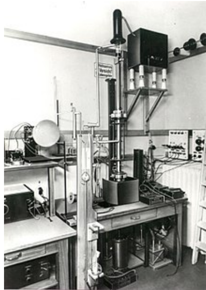
Figura 4.4: Primer microscopio electrónico de barrido desarrollado por Manfred von Ardenne en 1938.
