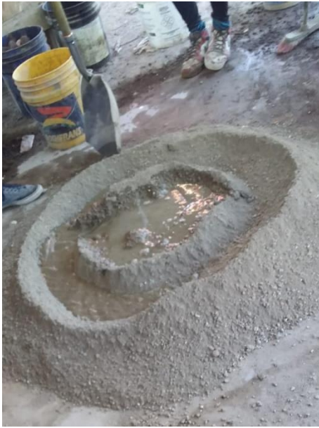
Figura 22. Mezcla para elaborar los bloques (Fuente propia).
