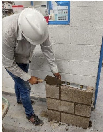
Figura 78. Elaboración del murete (Fuente propia).
