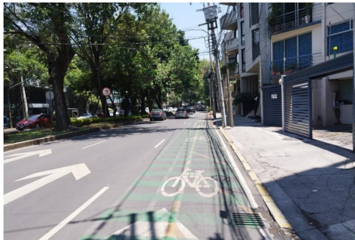
Figura 53. Sección de ciclovía en Avenida división del Norte en la colonia Del Valle
