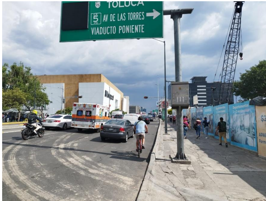
Figura 59. Avenida Cuauhtémoc cruce con Viaducto Pte. M. Alemán
