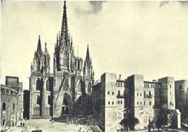
Fotografía 3.13. En 1888, Viollet-Le-Duc intervino la fachada de la catedral de Barcelona completamente al estilo Neogótico, con motivo de la Exposición Universal de 1888; se levantó una nueva portada principal, un cimborrio y dos torres con pináculos ornamentados.
