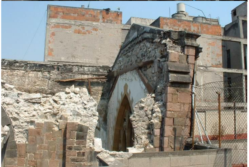
Fotografía 4.14. Fotografía del interior de Christ Church, donde se puede apreciar el colapso de la cubierta y los daños en la estructura (fotografía superior derecha).
