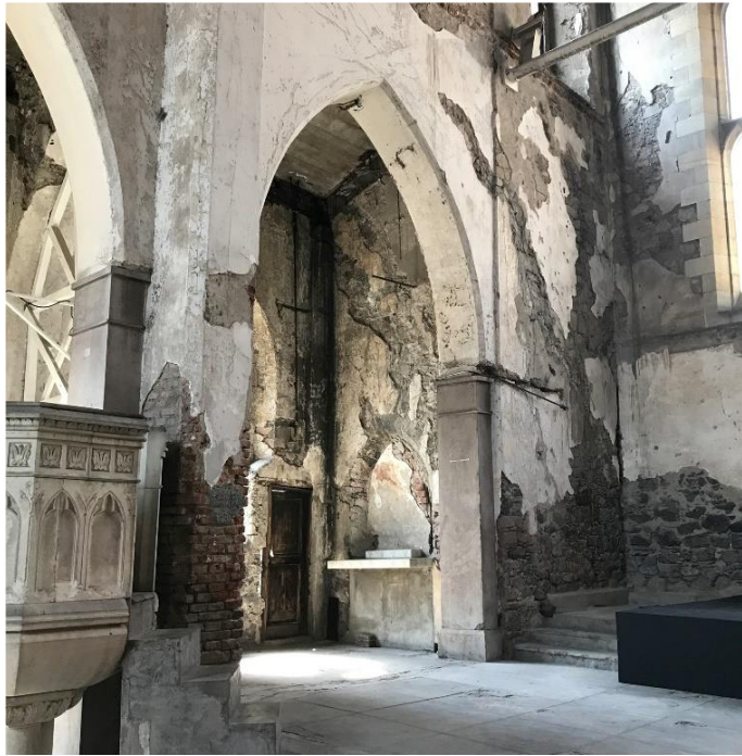
Fotografía 4.11. Fotografía de los daños ubicados al interior del inmueble por intemperismo (fotografía superior izquierda).
