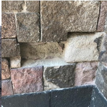
Fotografía 4.13. Fotografía de la fachada exterior, donde se muestra la pérdida de elementos pétreos (fotografía inferior derecha).
