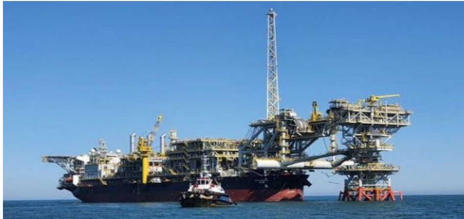
Fig. (56). FPSO MIAMTE MV34 de MODEC, Inc. en la Bahía de Campeche, México. Proyecto inyección de agua Eni México (Deepwater, 2022).
