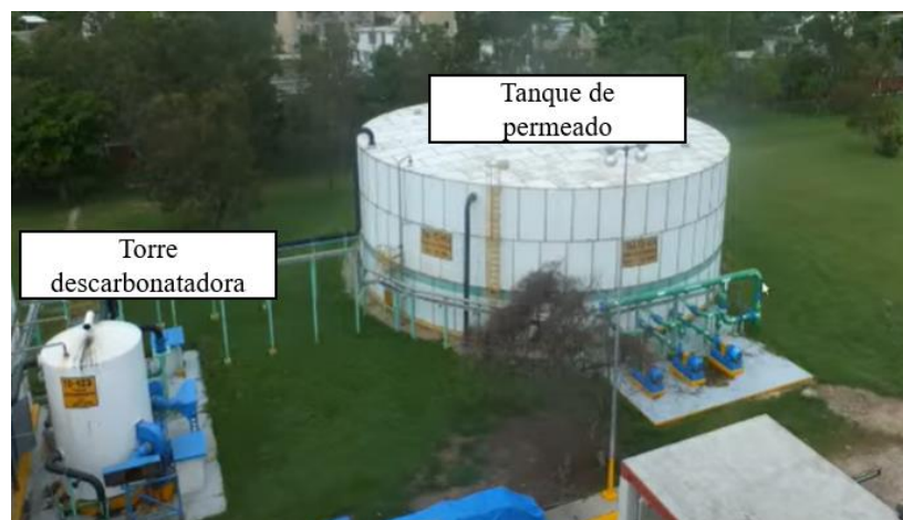
Fig. (65). Tanque de permeado, planta de tratamiento de aguas residuales de la refinería Madero (Cisneros, 2022)
