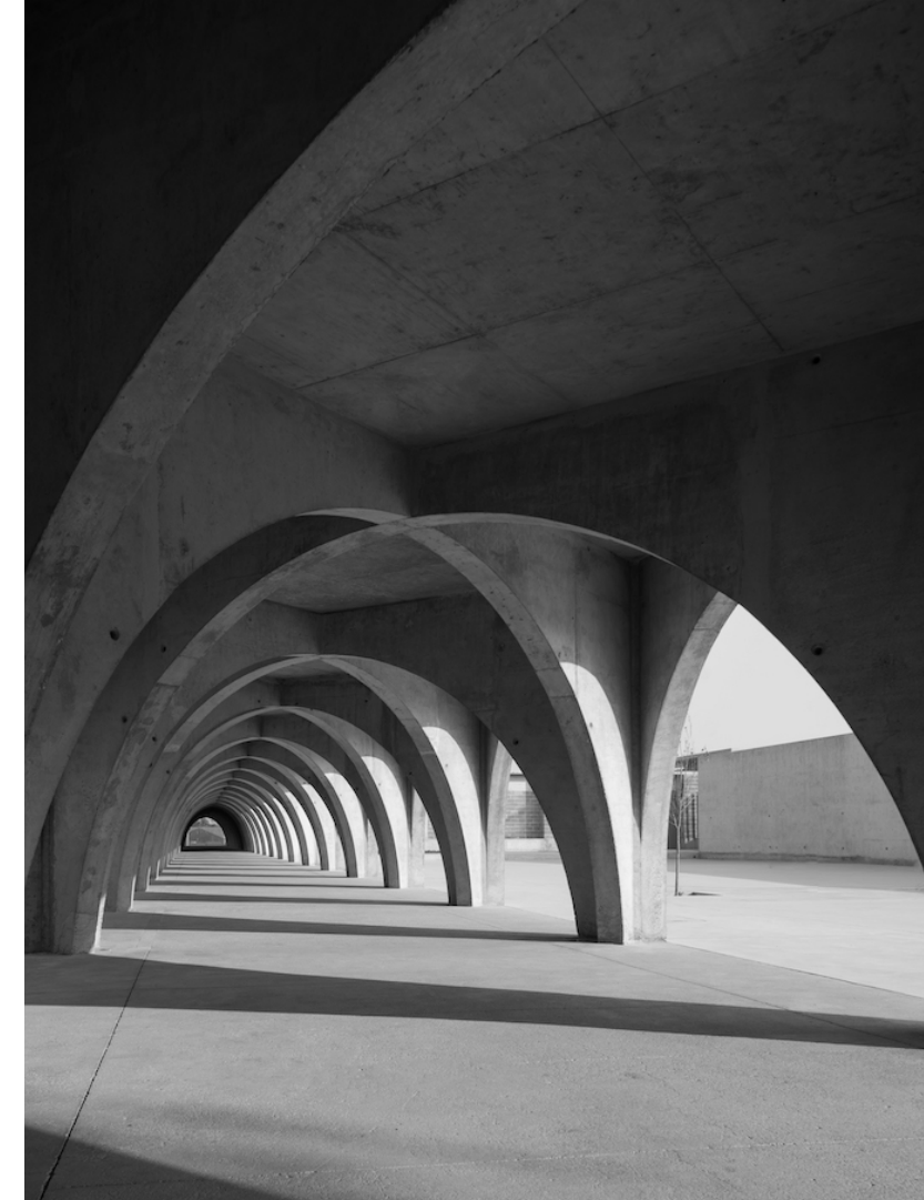
Imagen 110 Pasillo del CNYN del Estado de México en Chiconautla. Fuente: Arquine (2019)
