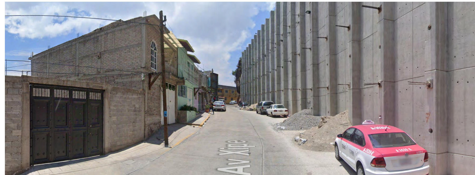
Imagen 079 Vista desde la calle Xipe de una sección del muro de contención para deslaves. Fuente: Google Street View (2021)
