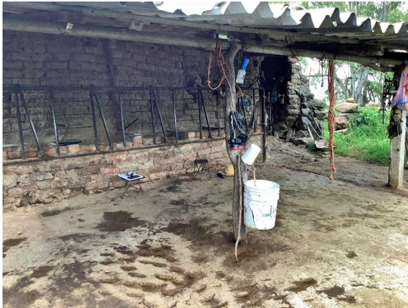
A4.2.2 Activo Fijo: Sala de ordeña
