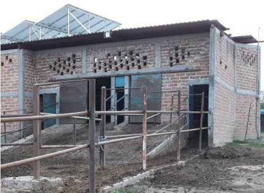
A4.7.2 Activo Fijo: Sala de ordeña
