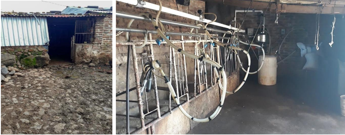
A4.3.2 Activo Fijo: Sala de ordeña
