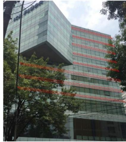
Figura 33. Propuesta de partes sombreadoras tipo "louvers" en la fachada Este 1
