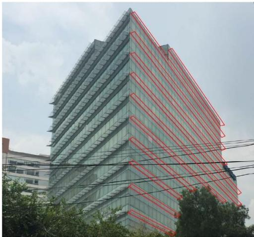
Figura 32. Propuesta de partes sombreadoras tipo "louvers" en la fachada Este 2
