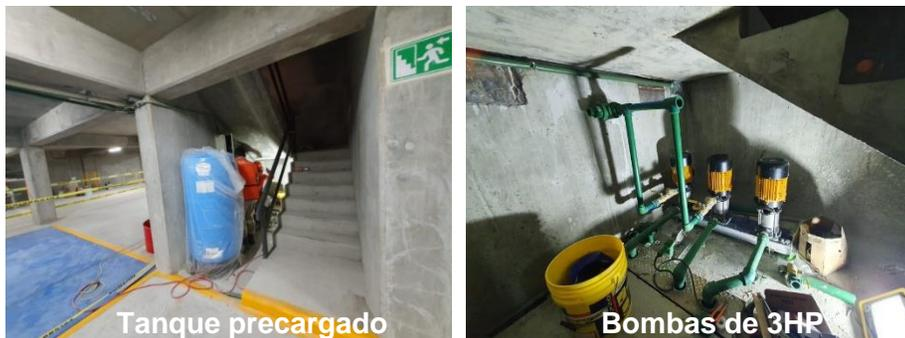
**Imagen 63. Componentes del hidroneumático**
