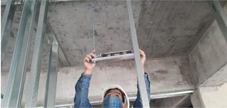
**Imagen 69. Colocación y nivelación de Unicanal**
