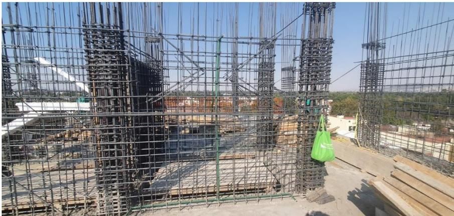
**Imagen 75. PP-R dentro de armado estructural**
