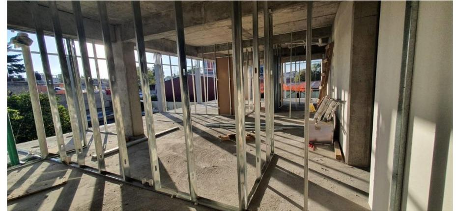
**Imagen 68. Estructura de muros divisorios**
