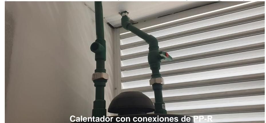
**Calentador con conexiones de PP-R**
