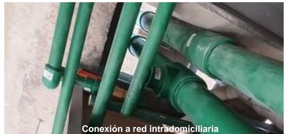
**Imagen 66. Montaje de redes de distribución en ductos**
