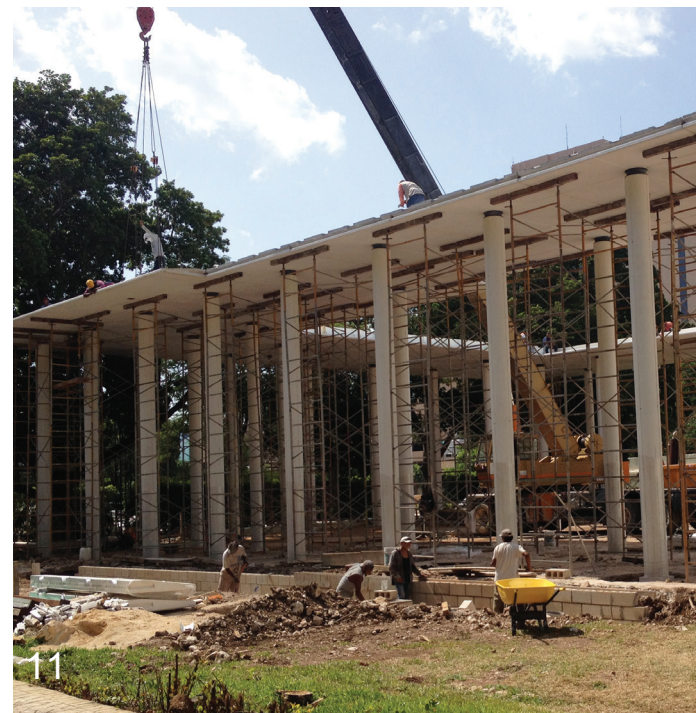
Fotos 9, 10 y 11: Muestran proceso constructivo de cubierta. Se inició con montaje de columnas para posteriormente ensamblar paneles o tabletas de concreto (losas), las cuales eran cargadas temporalmente por andamios metálicos. Todo esto mientras se concluían conexiones a traves metálicas invertidas arriba de cubierta.
