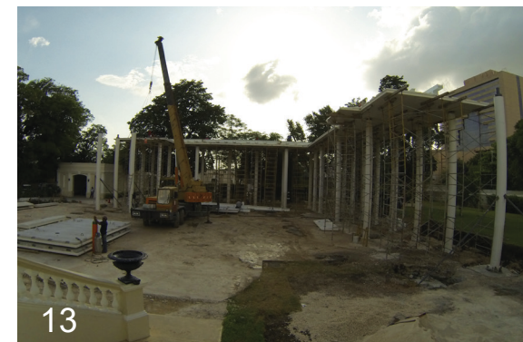
Foto 13: Muestra los diferentes procesos y componentes de obra. Mientras se montaban piezas prefabricadas en sitio, el taller de prefabricados seguía produciendo otros elementos. Pueden apreciarse paneles colocados en el piso recién llegados del taller.
