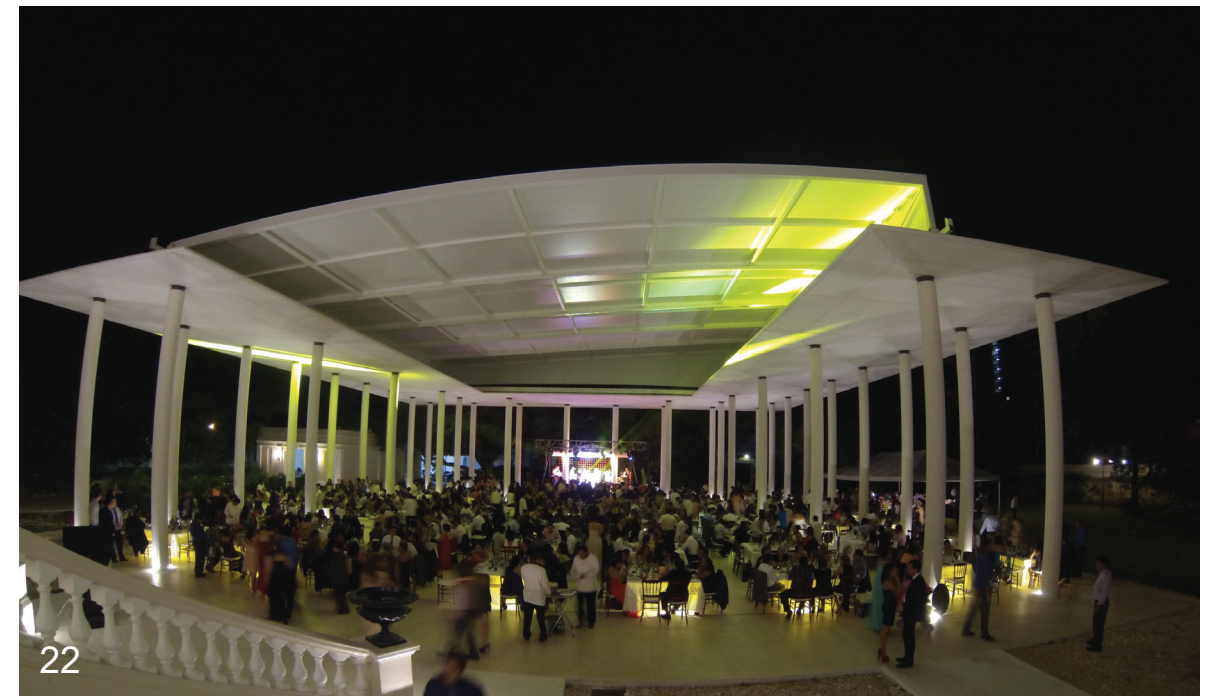
Fotos 21 y 22: Muestran la cubierta retráctil desplegada sobre el pabellón.
