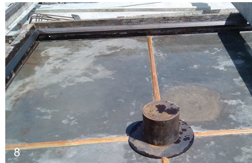
Fotos 7 y 8: muestran los elementos metálicos que permitirían las conexiones entre elementos metálicos y elementos de concreto.
