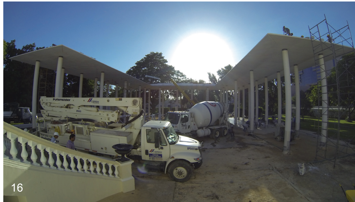
Foto 16: Muestra cubierta libre de andamios, esto fue posible una vez concluidos los montajes de traves metálicas invertidas.
