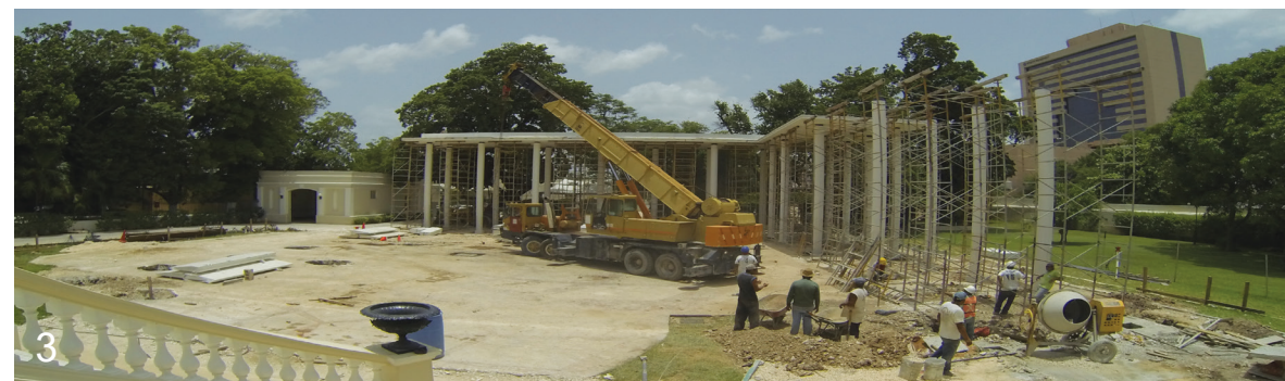
Fotos 2 y 3: Muestran la secuencia de montaje de estructura. Primero se montó la estructura de la parte posterior, posteriormente el ala derecha y finalmente el a la izquierda; todo esto para permitir el acceso y salida de grúas.
