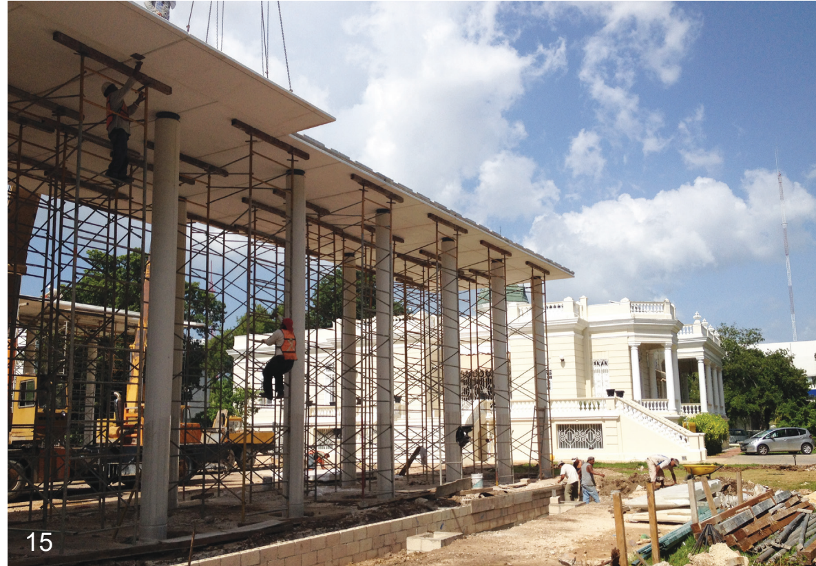
Foto 15: Muestra cómo se elaboraron piezas independientes para los bordes de la cubierta, esto con la intención de disminuir peraltes en bordes para lograr una percepción de ligereza en toda la cubierta.
