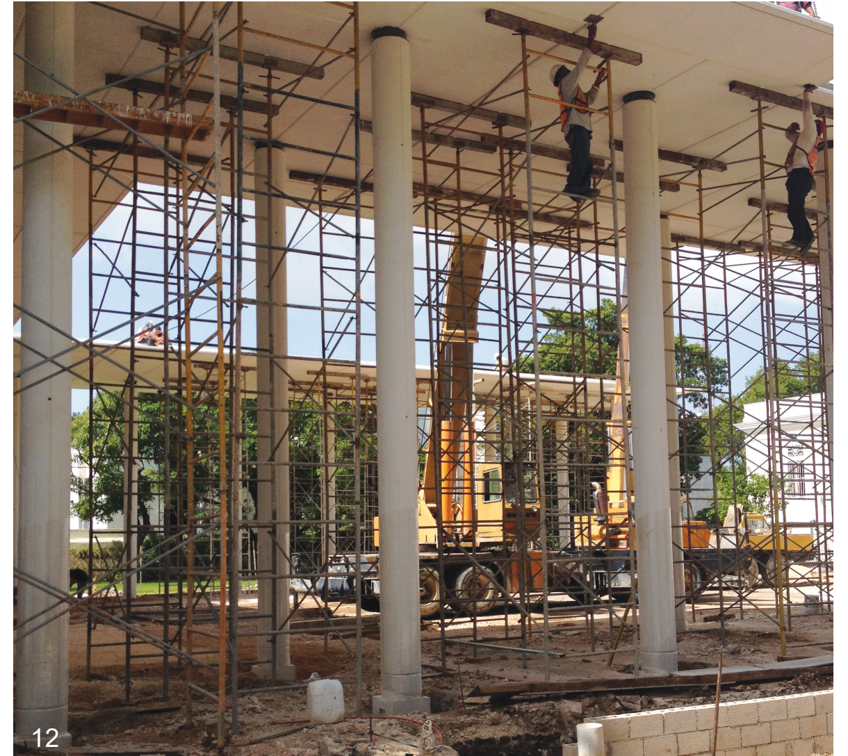
Foto 12: Muestra el trabajo simultáneo de conexiones en parte inferior y superior de cubierta
