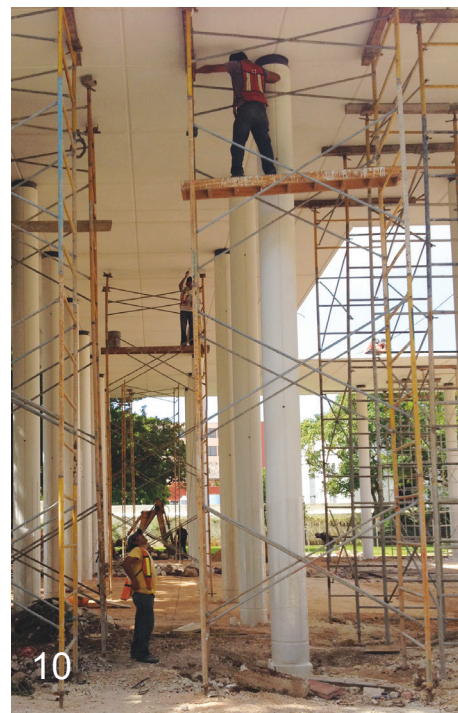
Fotos 9, 10 y 11: Muestran proceso constructivo de cubierta. Se inició con montaje de columnas para posteriormente ensamblar paneles o tabletas de concreto (losas), las cuales eran cargadas temporalmente por andamios metálicos. Todo esto mientras se concluían conexiones a traves metálicas invertidas arriba de cubierta.
