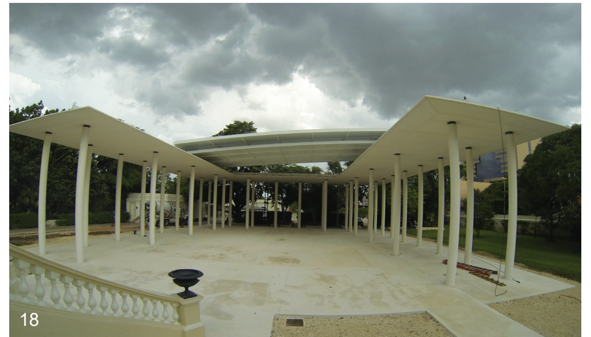
Fotos 17 y 18: Muestran el proceso de montaje de cubierta retráctil para cubrir pabellón en caso de lluvia. Cuatro marcos metálicos forrados de lona son capaces de apilarse uno dentro de otro para quedar ocultos en la parte posterior de cubierta.
