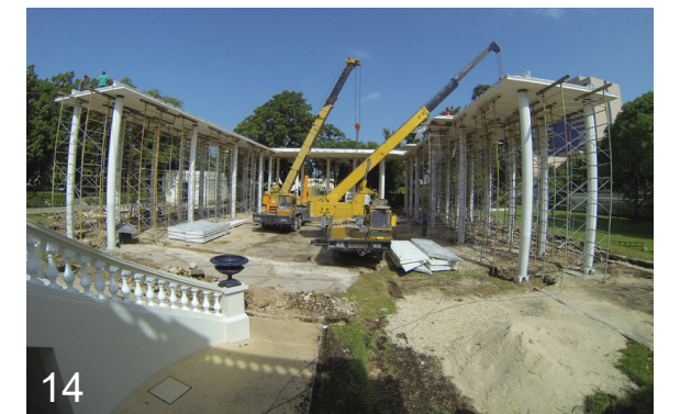
Foto 14: Muestra el trabajo de grúas montando traves metálicas en parte superior de cubierta.
