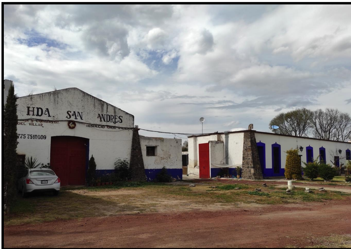
Fig. 34. Vista de la fachada de la hacienda de San Andrés.
