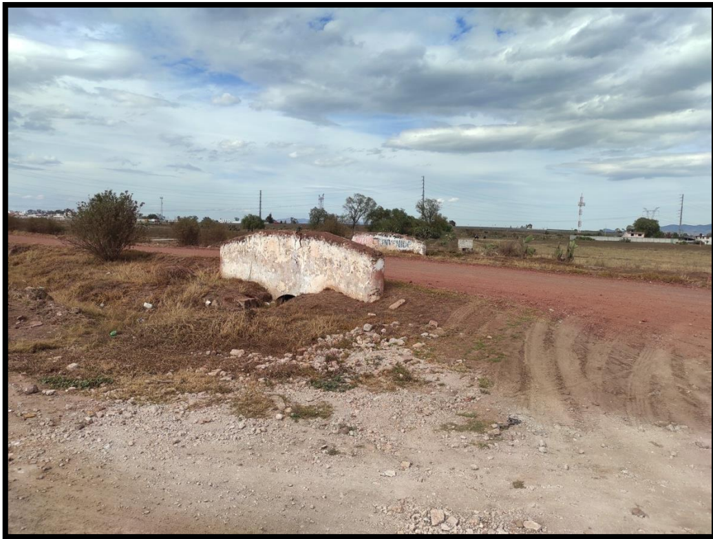
Fig. 30. Puente histórico que forma parte del Camino Real de San Nicolás El Chico.
