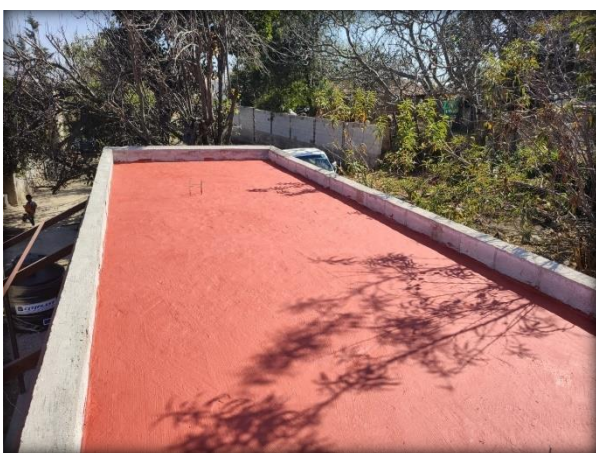
Fig. 127. Casa impermeabilizada. Elaboración Propia.
