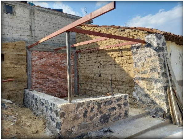
Fig. 113. Estructura de Pórtico. Elaboración Propia.
