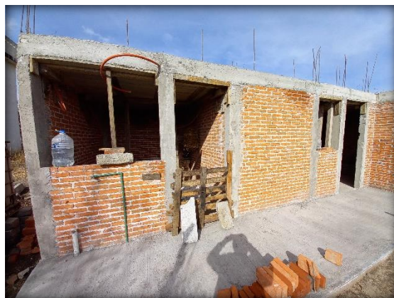
Fig. 102. Cadena de Cerramiento. Elaboración Propia.
