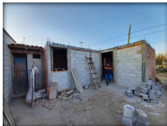
Fig. 100. Armado de Cadena de Cerramiento. Elaboración Propia.
