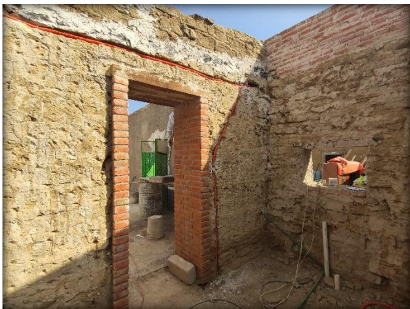
Fig. 107. Ranura en muro para instalación eléctrica. Elaboración Propia.
