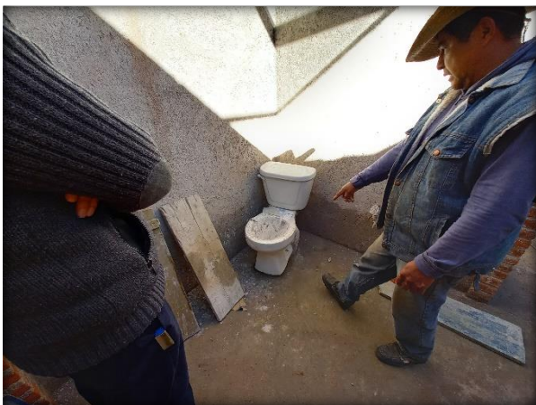
Fig. 121. Replanteo de ubicación de inodoro. Elaboración Propia.
