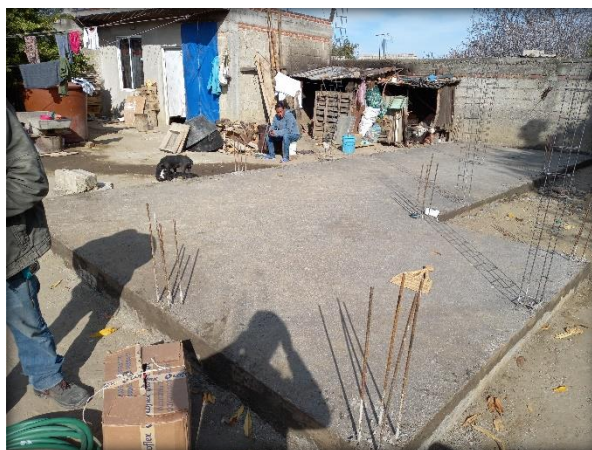
Fig. 94. Salidas de varilla para amarre de Castillos. Elaboración Propia.
