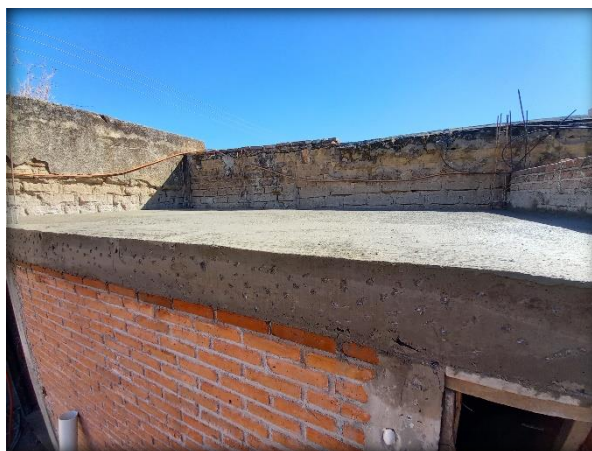
Fig. 106. Losa de vigueta y bovedilla. Elaboración Propia.
