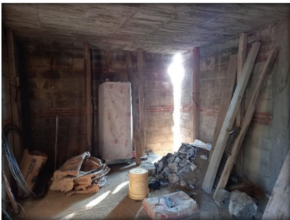
Fig. 145. Apuntalamiento para evitar debilitar la estructura. Elaboración Propia.
