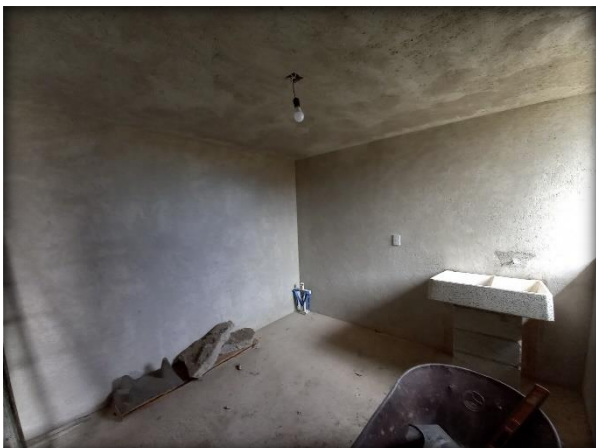
Fig. 129. Aplanado interno. Elaboración Propia.
