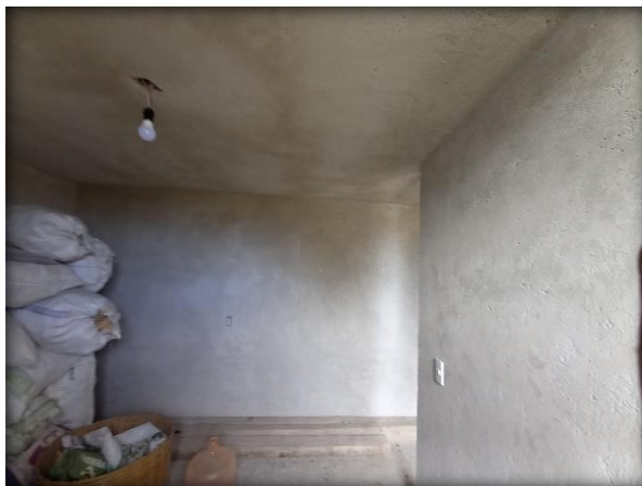
Fig. 108. Interruptor y Foco. Elaboración Propia.
