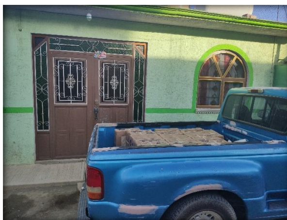
Fig. 134. Herrería en Puerta y ventana. Elaboración Propia.
