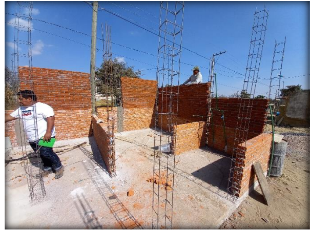
Fig. 98. Construcción de Muro de Tabique. Elaboración Propia.
