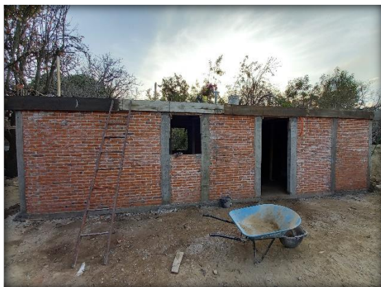
Fig. 101. Encofrado de Cadena de Cerramiento. Elaboración Propia.
