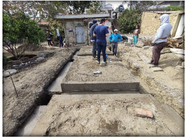
Fig. 80. Excavación terminada. Elaboración Propia.
