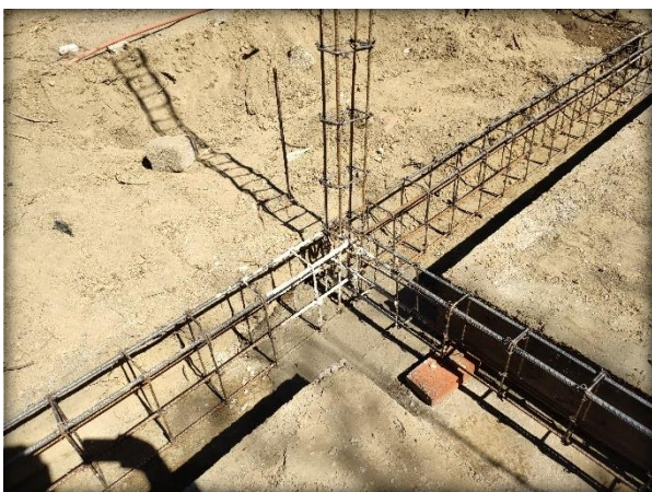
Fig. 93. Unión de Castillos a Contratrabe. Elaboración Propia.
