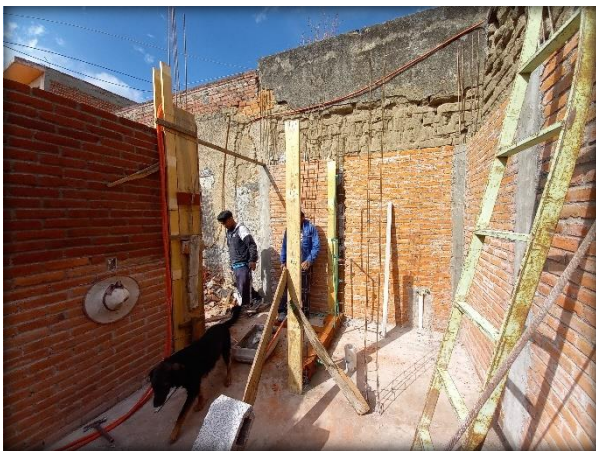
Fig. 95. Encofrado de Castillos. Elaboración Propia.
