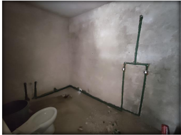
Fig. 126. Ranura de muro para colocación de tubería. Elaboración Propia.
