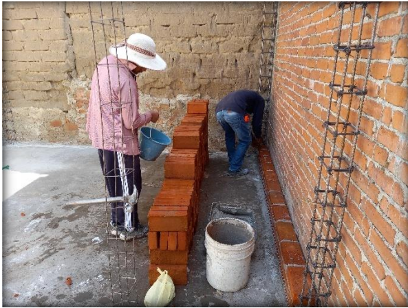
Fig. 97. Construcción de Muro de tabique. Elaboración Propia.
