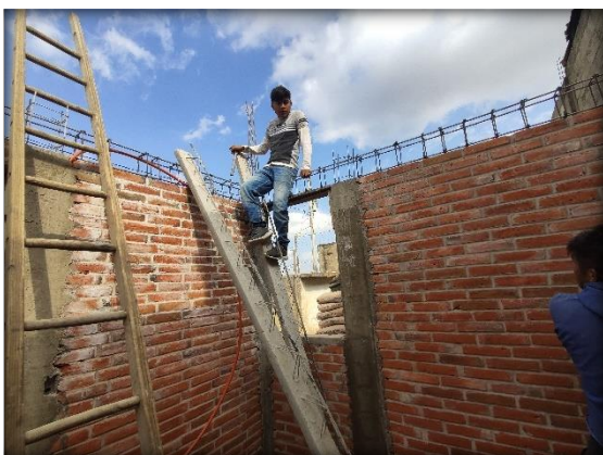
Fig. 99. Armado de Cadena de Cerramiento. Elaboración Propia.
