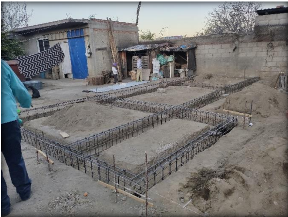
Fig. 81. Armado de Cimentación. Elaboración Propia.
