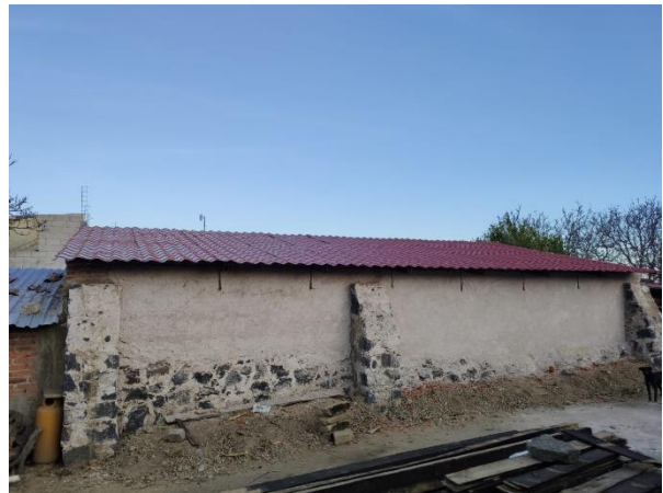
Fig. 164. Cubierta de plastiteja colocada en vivienda. Elaboración Propia.
