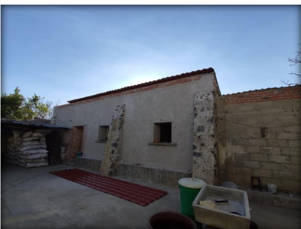
Fig. 131. Aplanado exterior. Elaboración Propia.
