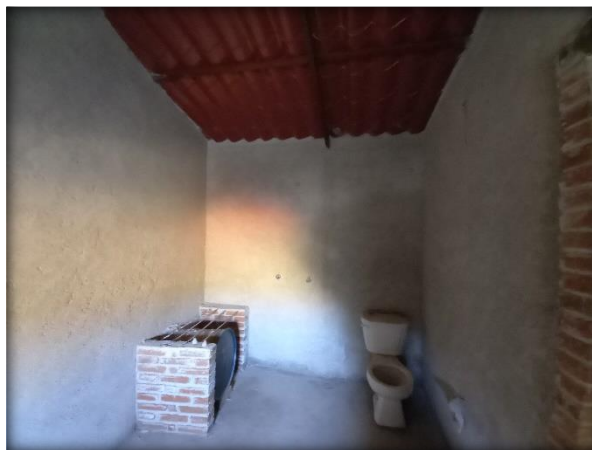
Fig. 122. Inodoro Colocado. Elaboración Propia.
