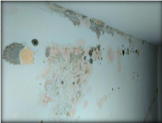
Fig. 2. Humedad por Condensación. HUMITAT-STOP. https://www.humitat-stop.com/humedad-por-condensacion (España, 2023)
