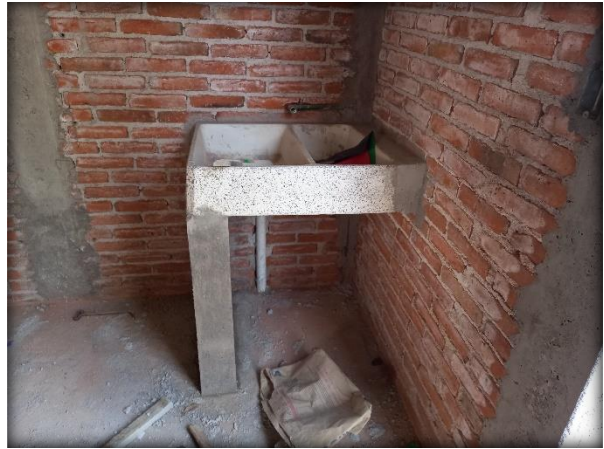
Fig. 124. Lavadero colocado. Elaboración Propia.
