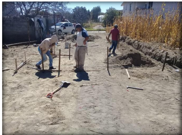
Fig. 78. Realización de trazo. Elaboración Propia.
