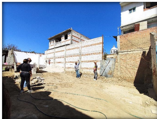
Fig. 76. Terreno después de Limpieza y Deshierbe. Elaboración Propia.
