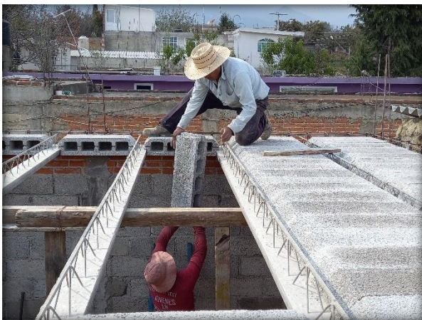
Fig. 103. Colocado de vigueta y bovedilla. Elaboración Propia.
