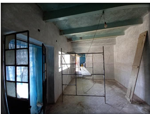
Fig. 135. Antes de aplicar pintura. Elaboración Propia.
