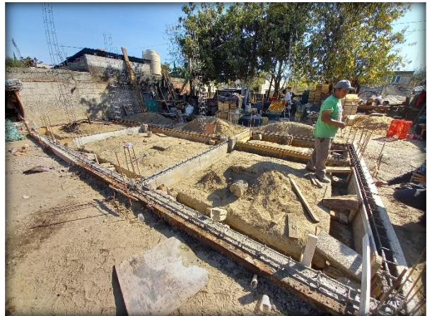
Fig. 82. Encofrado de cimentación. Elaboración Propia.
