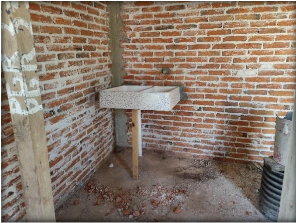
Fig. 123. Colocación de lavadero. Elaboración Propia.
