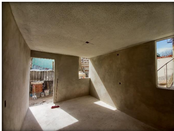
Fig. 130. Aplanado interno. Elaboración Propia.
