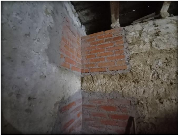
Fig. 155. Rehabilitación de muro de adobe con tabique. Elaboración Propia.
