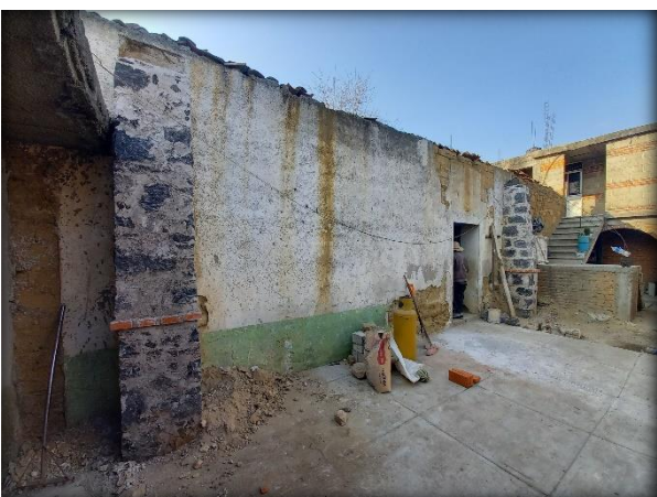
Fig. 151. Contrafuertes. Elaboración Propia.
