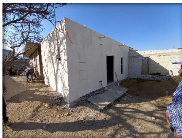
Fig. 132. Aplanado exterior. Elaboración propia.
