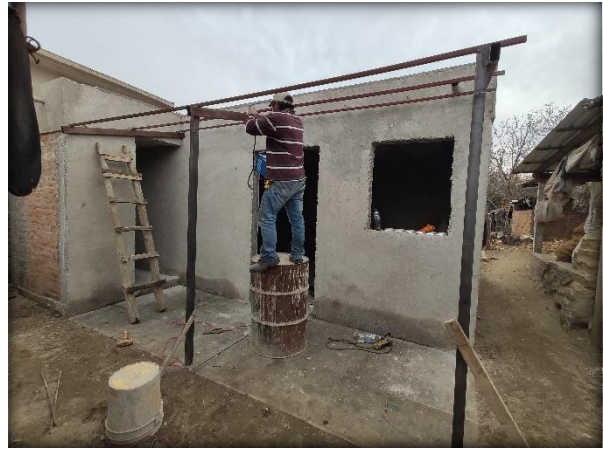
Fig. 114. Estructura de Pórtico. Elaboración Propia.
