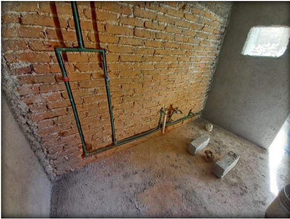
Fig. 125. Ranura de muro para colocación de tubería. Elaboración Propia.
