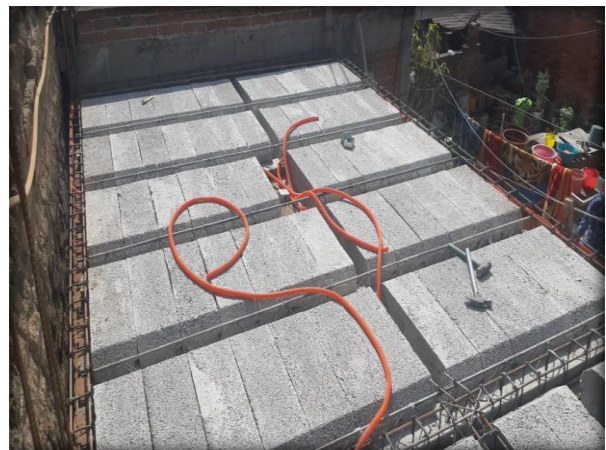
Fig. 104. Losa de vigueta y bovedilla. Elaboración Propia.
