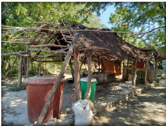
Fig. 45. Cubierta ligera de palma. Elaboración Propia.
