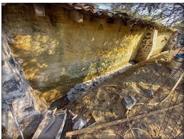
Fig. 83. Cimentación de Mampostería. Elaboración Propia.
