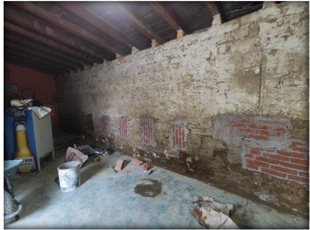
Fig. 156. Rehabilitación de muro de adobe con tabique. Elaboración Propia.
