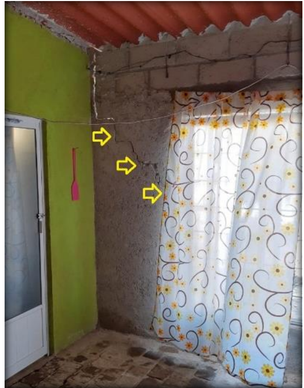
Fig. 9. Asiento diferencial, ejemplo 2. Elaboración Propia.
