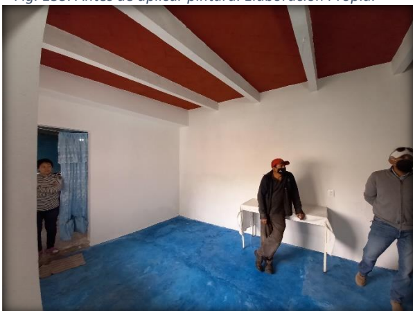
Fig. 137. Después de aplicar pintura. Elaboración Propia.
