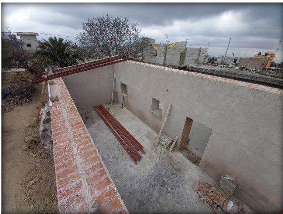
Fig. 161. Estructura para cubierta de plastiteja. Elaboración Propia.
