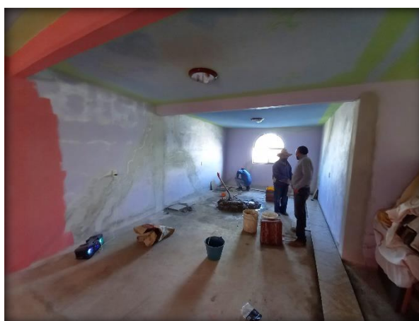
Fig. 136. Antes de aplicar pintura. Elaboración Propia.
