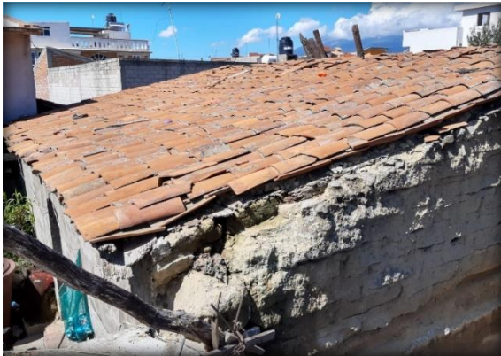
Fig. 47. Cubierta de Teja. Elaboración Propia.
