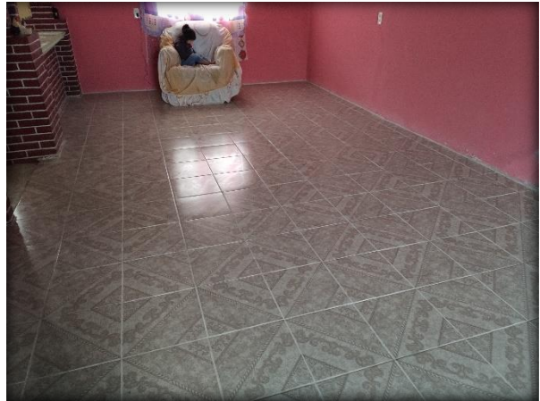
Fig. 140. Loseta colocada. Elaboración Propia.
