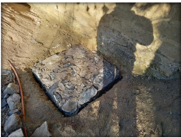
Fig. 149. Cimentación de contrafuerte. Elaboración Propia.
