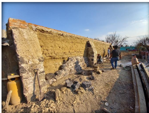
Fig. 150. Construcción de contrafuertes. Elaboración Propia.
