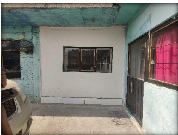
Fig. 133. Herrería en ventana. Elaboración Propia.
