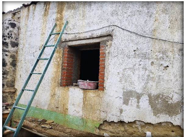
Fig. 158. Apertura de ventana en muro de adobe. Elaboración Propia.
