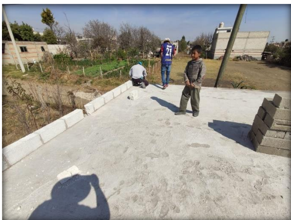
Fig. 109. Construcción de pretil. Elaboración Propia.
