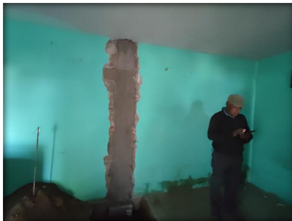
Fig. 148. Castillo colado en vivienda ya existente. Elaboración Propia.
