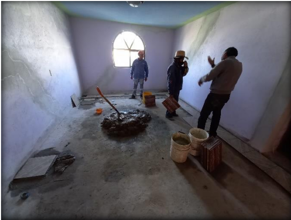
Fig. 139. Colocación de loseta. Elaboración Propia.
