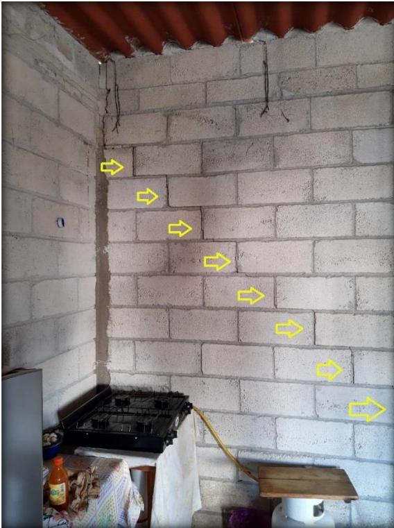
Fig. 8. Asiento diferencial, ejemplo 1. Elaboración Propia.
