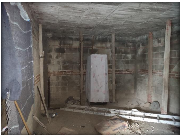
Fig. 147. Castillo colado en vivienda ya existente. Elaboración Propia.
