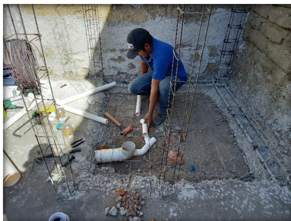
Fig. 86. Instalación Sanitaria. Elaboración Propia.
