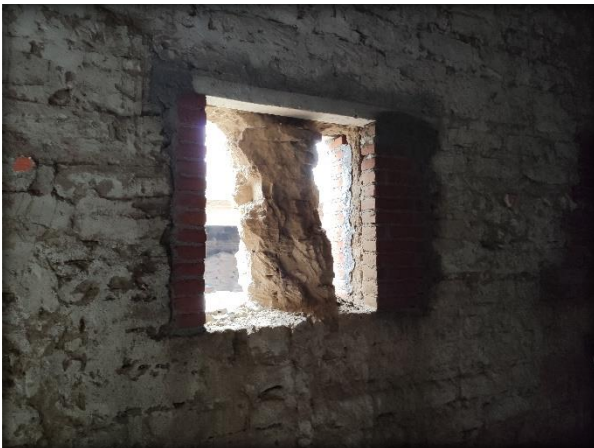
Fig. 157. Apertura de ventana en muro de adobe. Elaboración Propia.
