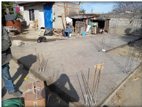
Fig. 92. Losa de Cimentación. Elaboración Propia.
