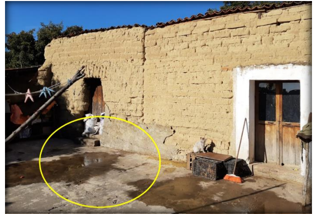
Fig. 44. Fractura en firme de concreto, ejemplo 3. Elaboración Propia.
