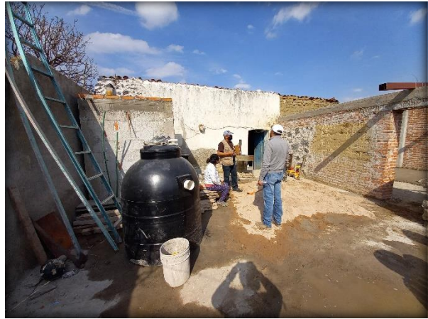
Fig. 88. Replanteo de ubicación del biodigestor. Elaboración Propia.
