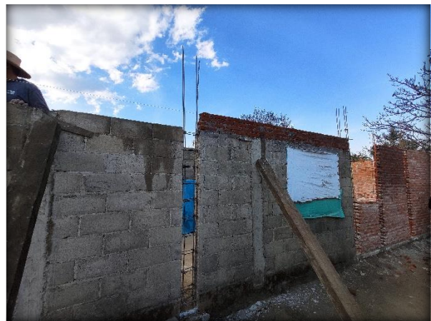
Fig. 146. Armado de castillo y apuntalamiento de muro. Elaboración Propia.
