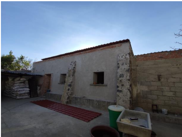
Fig. 163. Cubierta de plastiteja colocada en vivienda. Elaboración Propia.
