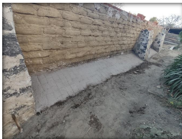
Fig. 84. Acabados de cimentación de Mampostería. Elaboración Propia.
