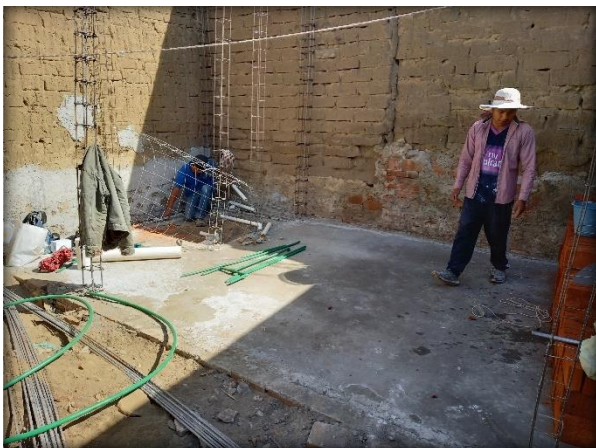
Fig. 91. Losa de Cimentación. Elaboración Propia.
