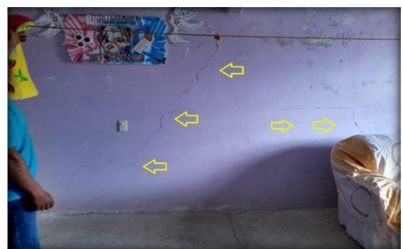
Fig. 12. Asiento diferencial, ejemplo 5. Elaboración Propia.
