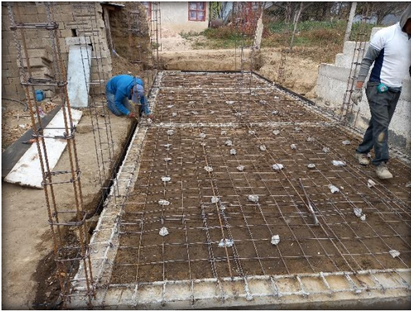
Fig. 89. Armado de losa de Cimentación. Elaboración Propia.
