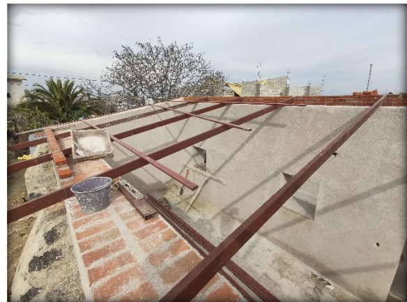
Fig. 162. Estructura para cubierta de plastiteja. Elaboración Propia
