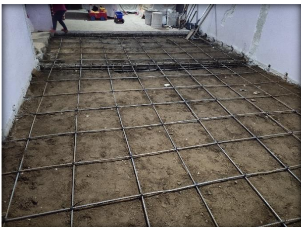
Fig. 153. Armado de losa de cimentación. Elaboración Propia.
