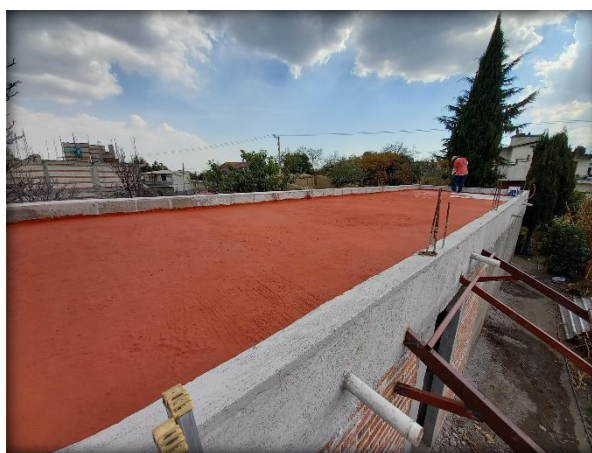
Fig. 128. Casa impermeabilizada. Elaboración Propia.
