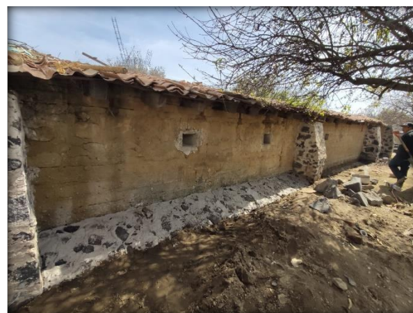
Fig. 152. Contrafuertes. Elaboración Propia.
