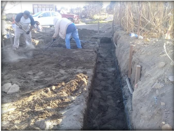
Fig. 79. Excavación de zanjas. Elaboración Propia.
