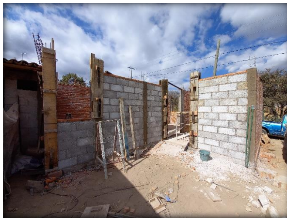
Fig. 96. Encofrado de Castillos. Elaboración Propia.
