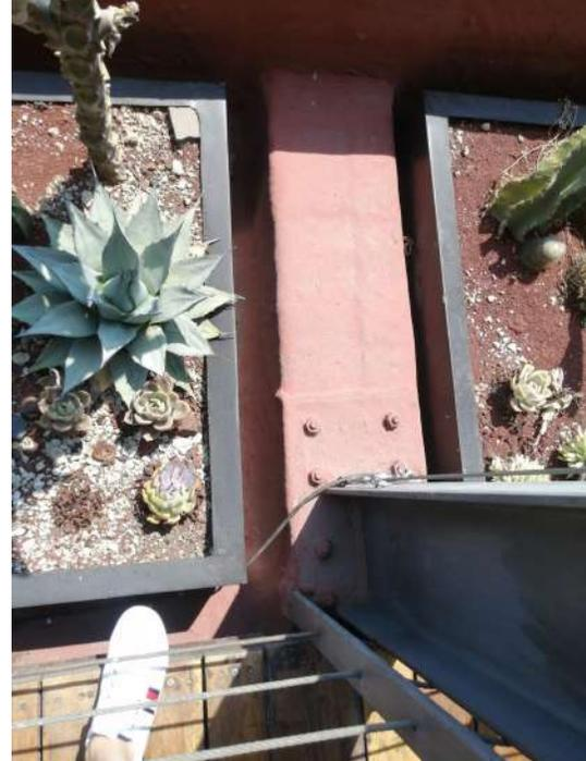
Fig 123. Detalle empotrado columna en viga
