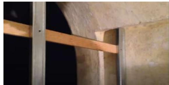
Fig 131. Empotre guías tablaroca logrado con madera apuntalada
