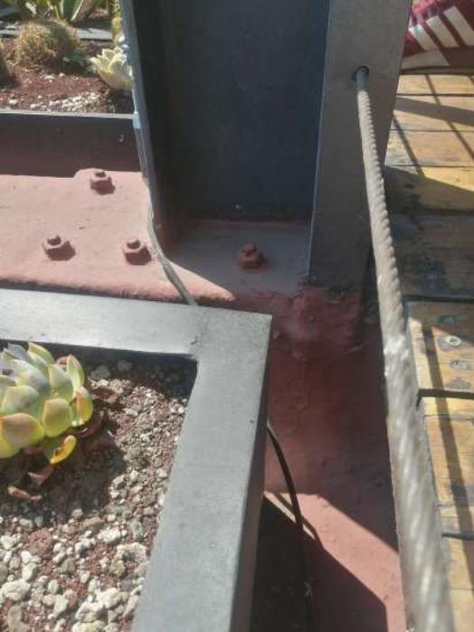
Fig 121. Detalle empotrado columna de acero
