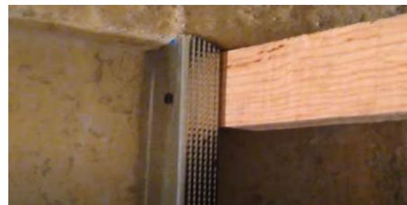
Fig 132. Empotre guías tablaroca logrado con madera apuntalada
