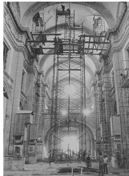
Fig 7. Tratamiento de las grietas en las bóvedas de la nave central
