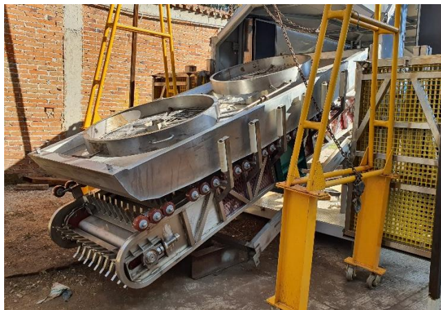
Imagen 56 Montaje de subsistema Barco sobre subsistema Extractor. Elaboración propia.
