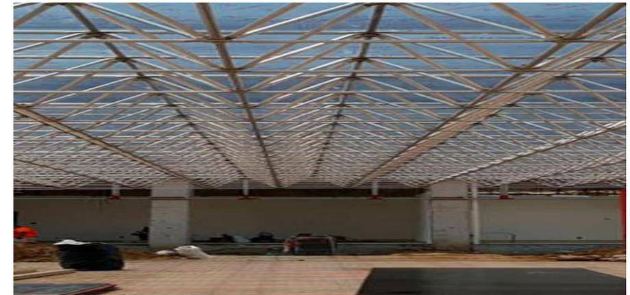
Ilustración 82. Armado del sistema de entrepiso tridilosa.
