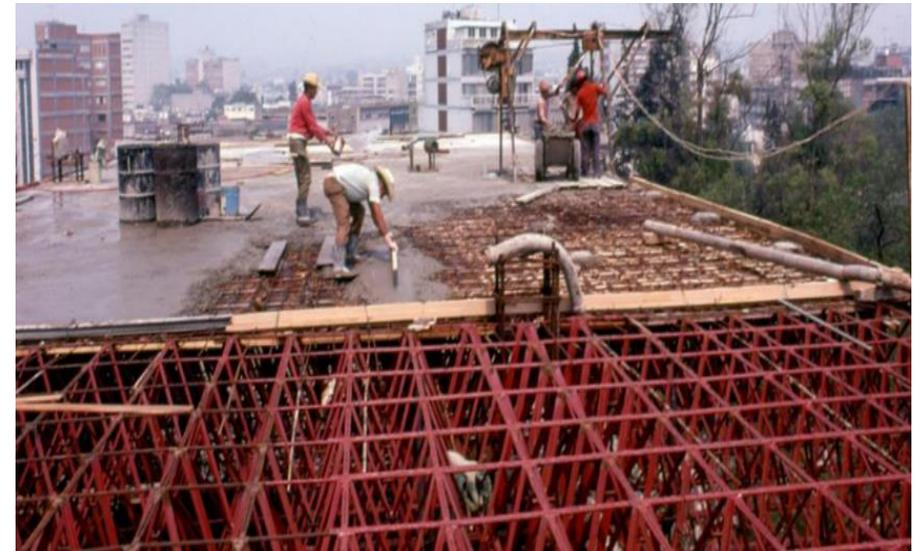
Ilustración 83. Colado de la losa superior de la sobre la tridilosa.
