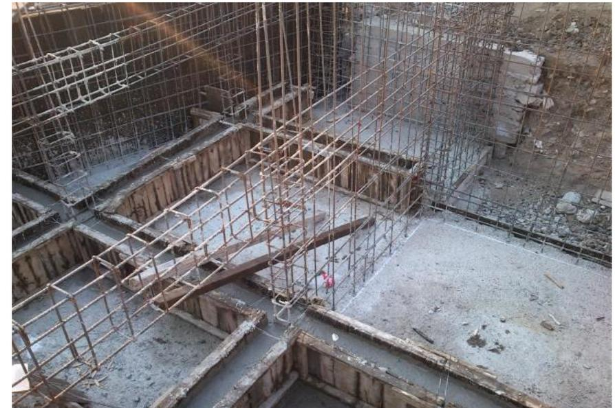
Ilustración 81. Colado de contratraveses para el cajón de cimentación.
