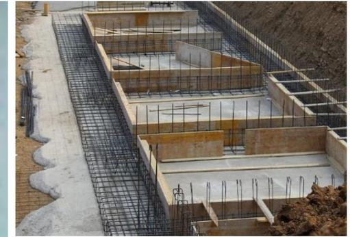
Ilustración 80. Cimbrado y armado.
