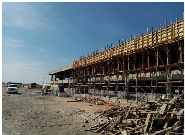
Fotografía No. 47 Referencia al Habilidadado, suministro y armado de acero de refuerzo de diferentes diámetros y Fotografía No. 48 Descimbra en pretiles (Multiconstrucciones Calvario, S. A. de C. V., 2022)
