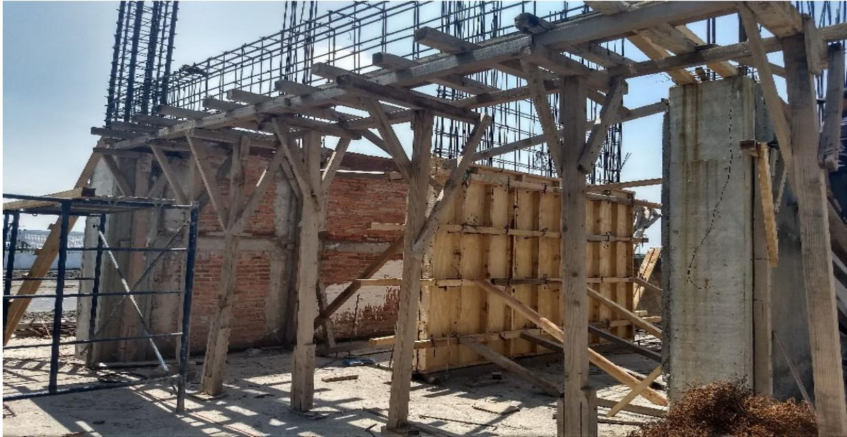
Fotografía No. 38 Referencia al estado en que se encontró la Cimbra en elementos estructurales de concreto de la etapa anterior (Multiconstrucciones Calvario, S. A. de C. V., 2022)
