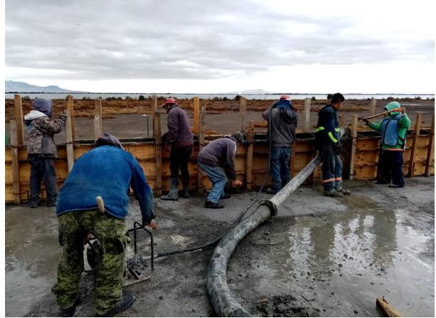
Fotografía No. 49 Referente al suministro de Losacero, malla electrosoldada fijada a pernos con un punto de soldadura y preparación de castillos para quedar ahogados en losa de entrepiso y Fotografía No. 50 colado de pretilos con concreto premezclado (Multiconstrucciones Calvario, S. A. de C. V., 2022)
