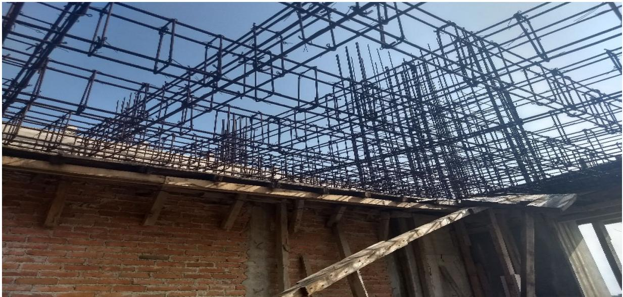
Fotografía No. 37 Referencia al estado de oxidación en que se encontró el acero de refuerzo de la etapa anterior en la Universidad Politécnica de Chimalhuacán (Multiconstrucciones Calvario, S. A. de C. V., 2022)
