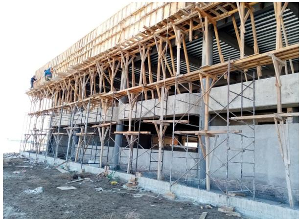
Fotografía No. 51 Referente al suministro de concreto premezclado  $f'c=200 \text{ kg/cm}^2$  en losa de entrepiso y Fotografía No. 52 Apuntalamiento y troquelado de cimbra en pretil de losa azotea (Multiconstrucciones Calvario, S.A. de C.V., 2022)
