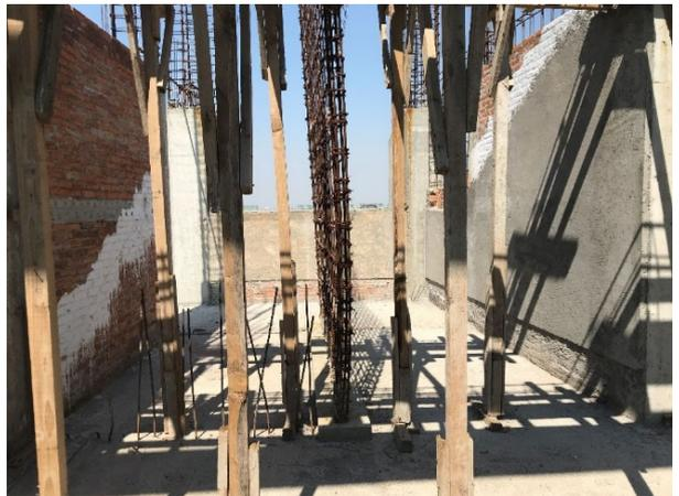
Fotografía No. 33 y Fotografía No. 34 Referencia al Desmantelamiento de la cimbra existente de la etapa anterior. (Multiconstrucciones Calvario, S.A. de C.V., 2022)
