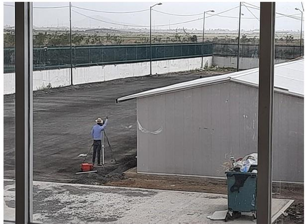
Fotografía No. 10 Referencia a la Supervisión de los trabajos conforme a Proyecto Entregado por la Dependencia y Fotografía No. 11 Levantamiento topográfico para desplante de edificios (Multiconstrucciones Calvario, S.A. de C.V., 2022)
