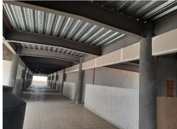
Fotografía No. 12 Referencia a los trabajos de Montaje de pasarela principal puente peatonal y Fotografía No. 13 Trabajos de colocación de acabados (Multiconstrucciones Calvario, S.A. de C.V., 2022)
