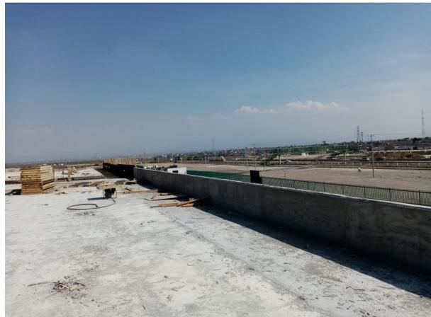
Fotografía No. 67 Suministro y colocación de cimbra en pretil de azotea, Fachada Principal Universidad Politécnica de Chimalhuacán (Multiconstrucciones Calvario, S.A. de C.V., 2022)
