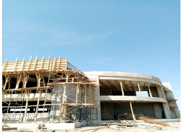
Fotografía No. 45 Referencia al habilitado de placas de acero estructural y Fotografía No. 46 Habilidadado de cimbra en pretiles (Multiconstrucciones Calvario, S. A. de C. V., 2022)
