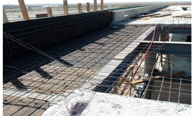
Fotografía No. 41 Referencia a la REVISIÓN DE NODOS EN ESTRUCTURA METÁLICA y Fotografía No. 42 trabajos de habilitado de cimbra y acero de refuerzo en losas (Multiconstrucciones Calvario, S.A. de C.V., 2022)
