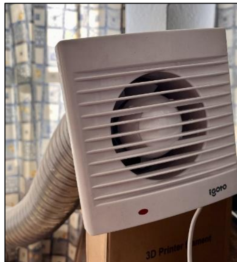
Figura 19. Extractor de aire Igoto Swiss EX4-16W y conexión con tubo flexible de 3'' x 2m.
