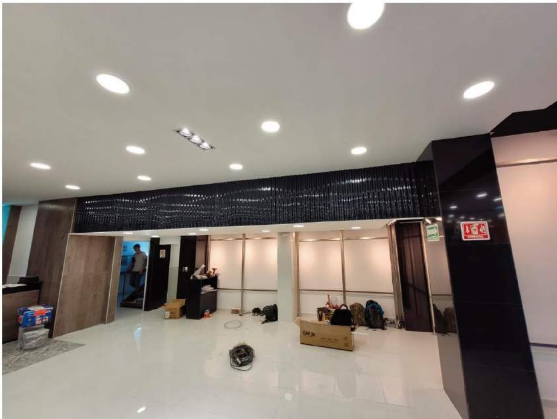
Interior de local final de obra.
