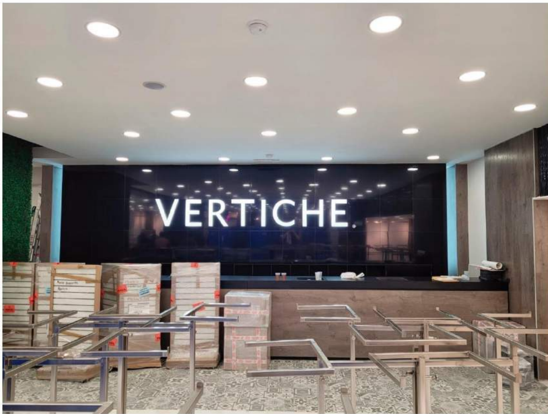
Interior de local final de obra.
