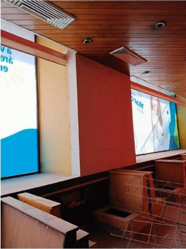
Interior de local inicio de obra.
