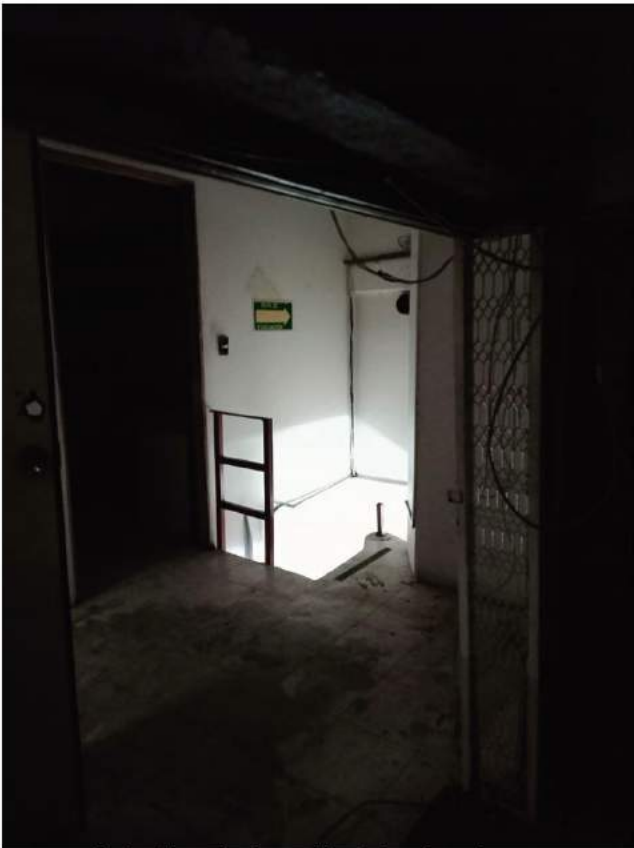
Interior de local inicio de obra.
