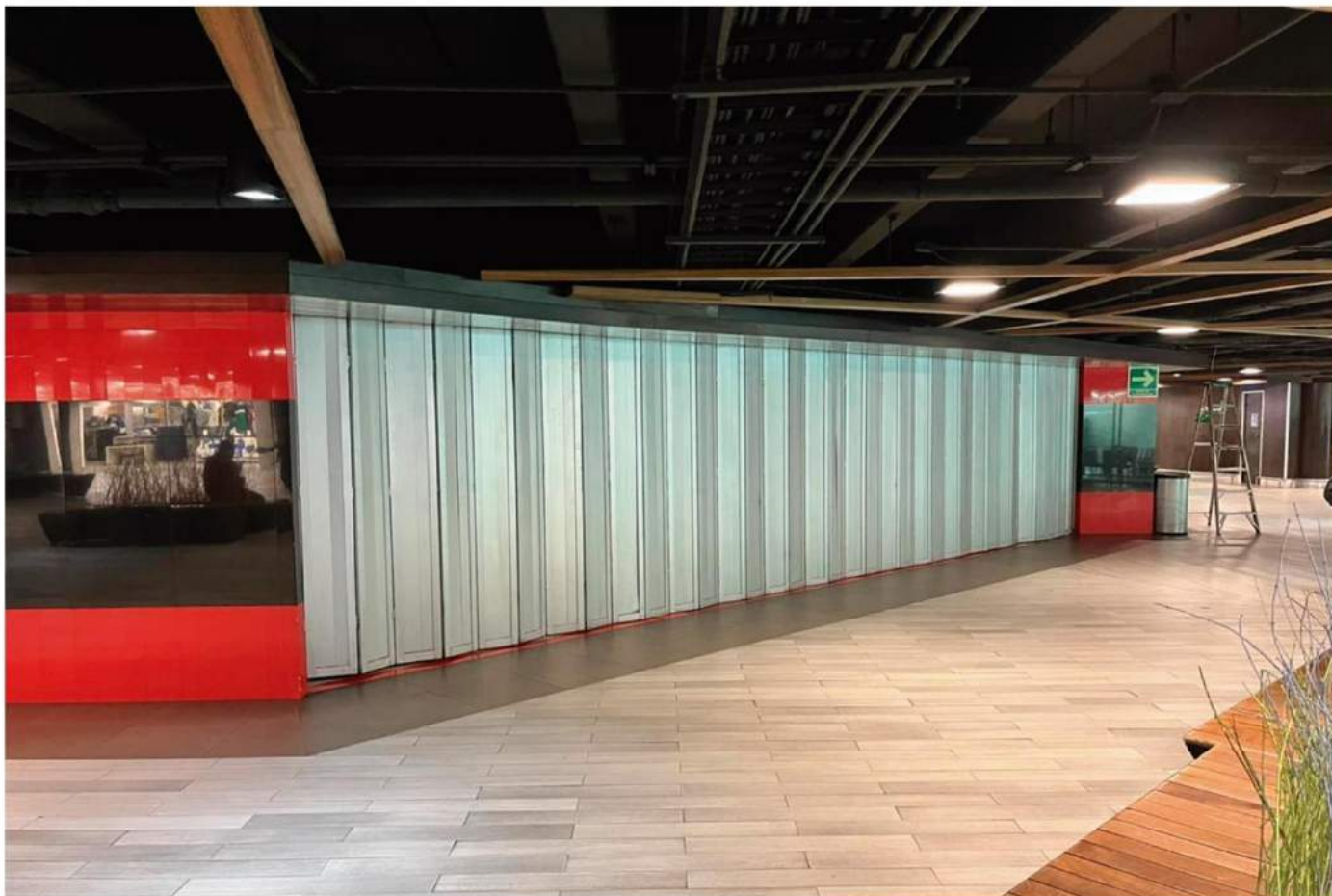
Fachada Puerta Ajusco.
