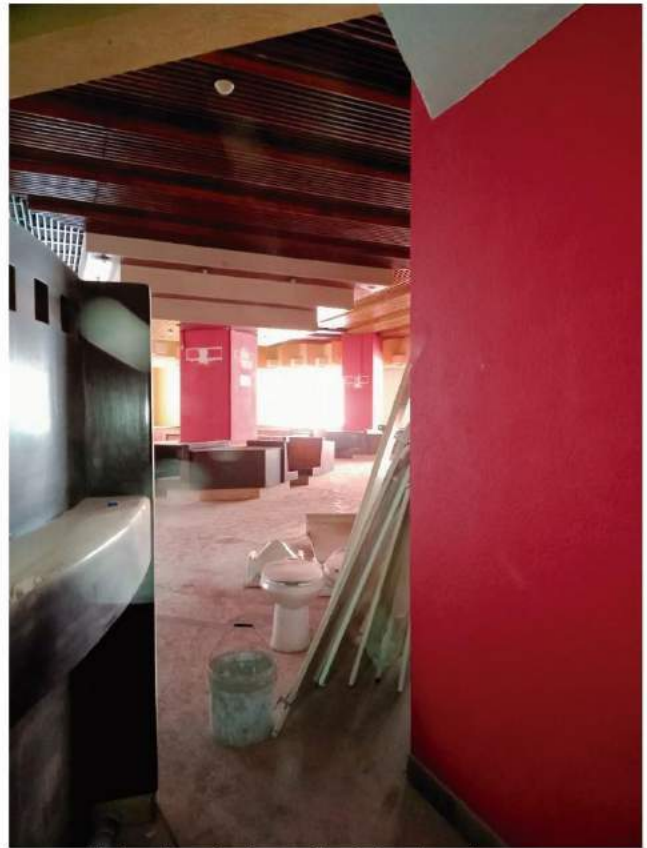
Interior de local inicio de obra.
