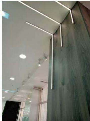
Columnas de piso laminado
