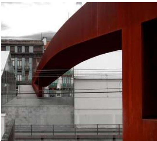
IMAGEN 170. Estructura cubierta de acero reciclado. Fuente: Ulbrinox
