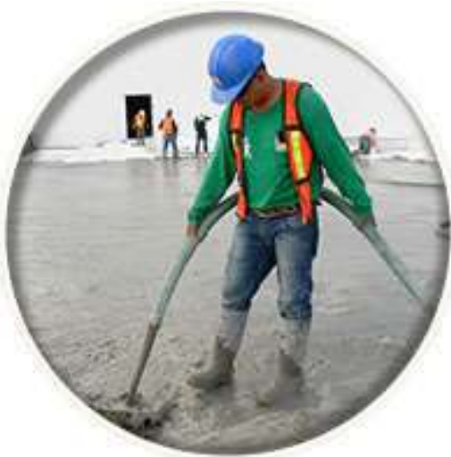
IMAGEN 169. Aplicación de concreto. Fuente: Curacreto
