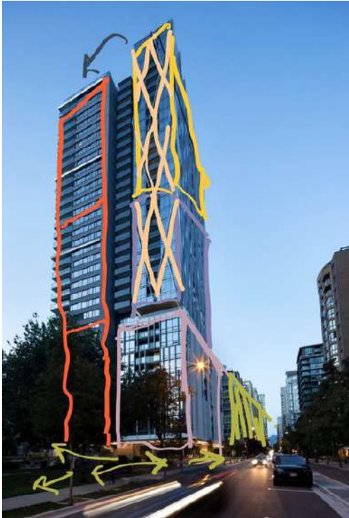
IMAGEN 128. Fotografía de fachada. Fuente: Ema Peter.
