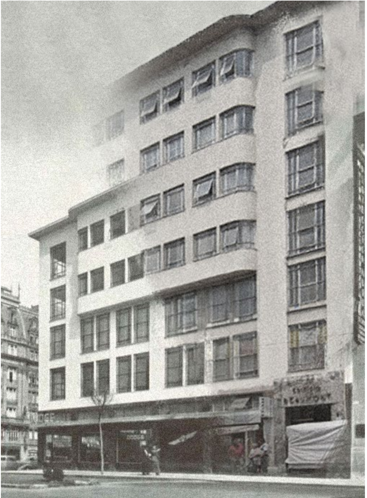
29. Alfonso Cervantes y Gonzalo Ortega, edificio Beaumont. Edificio intervenido.
