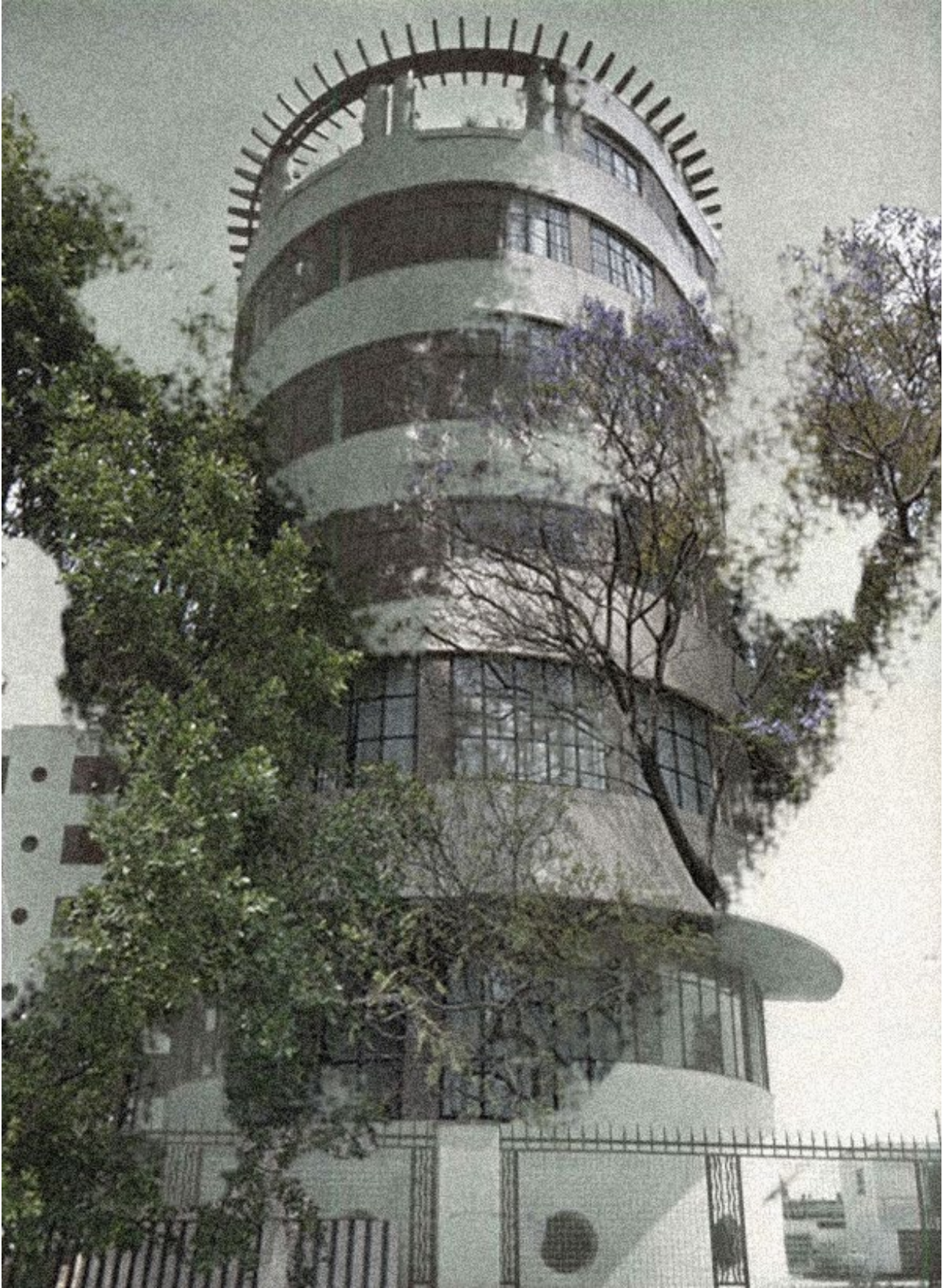
30. Carlos Greenham, Hospital de Ferrocarriles Nacionales. Edificio existente.
