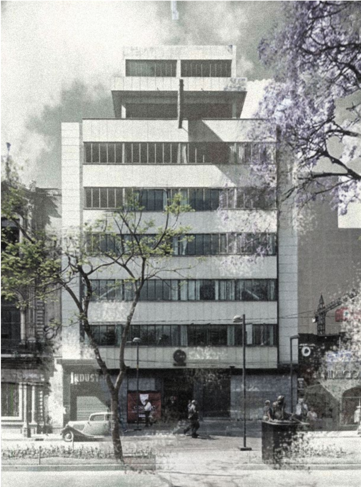
28. José Arnel, oficinas en Juárez 60. Edificio existente.
