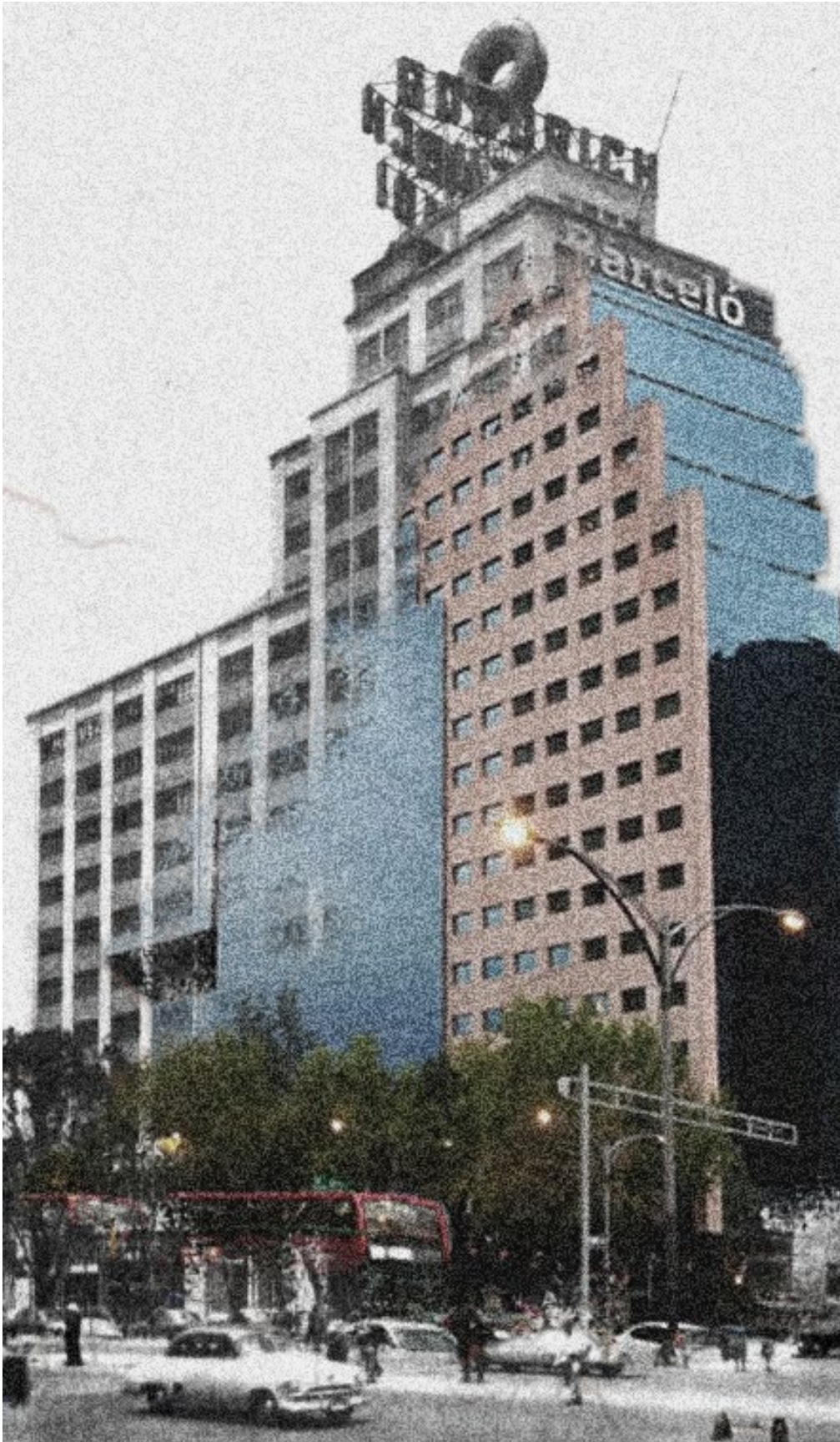
35. Luis y Francisco Martínez Negrete, Edificio Internacional (Corcuera). Demolido.
