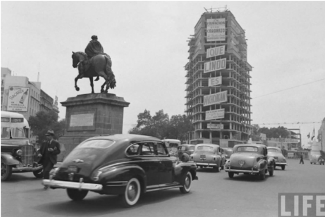
25. El Edificio Internacional (Corcuera), de Martínez Negrete, en construcción. LIFE Magazine .
