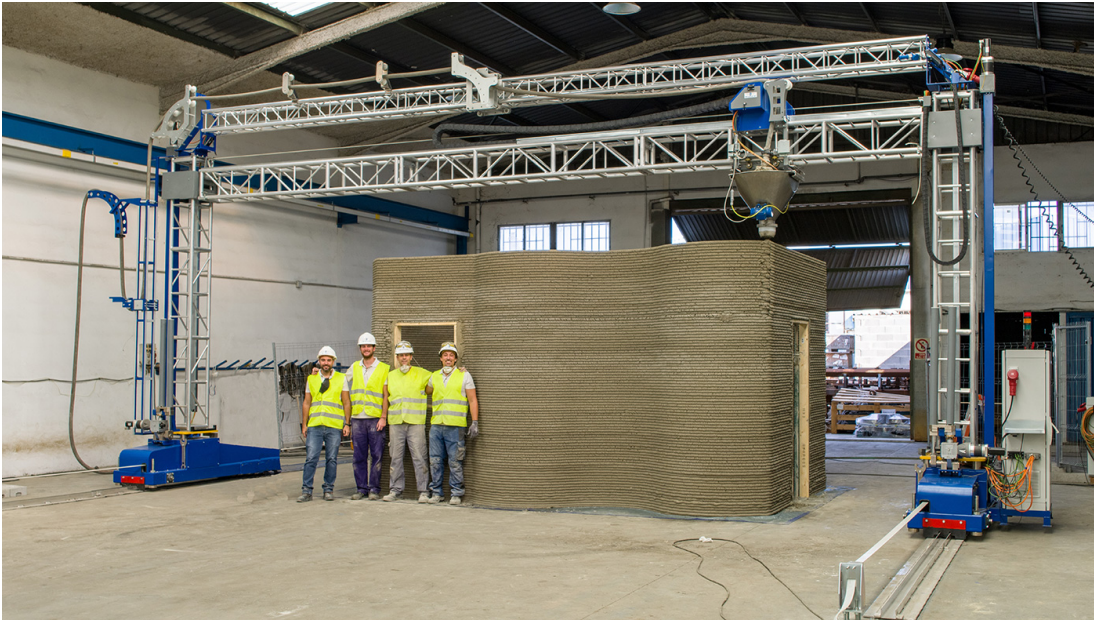
Figura 1.3: Construcción de viviendas haciendo uso de la manufactura aditiva, imagen tomada de www.bemore3d.com
