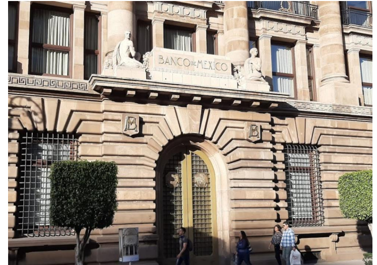
#11 Fachada Banco de México Jonathan Barrera (2020).
