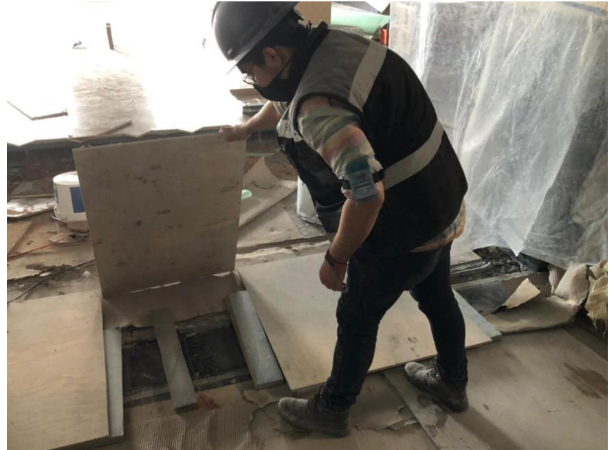
#13 revisión de instalaciones Jonathan Barrera (2020).
