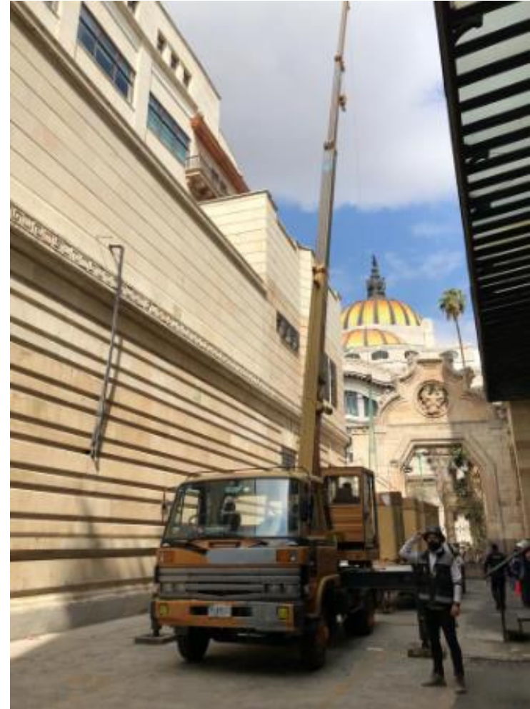
#89 Supervisión de ingreso de equipo de aire acondicionado. Jonathan Barrera (2021)
