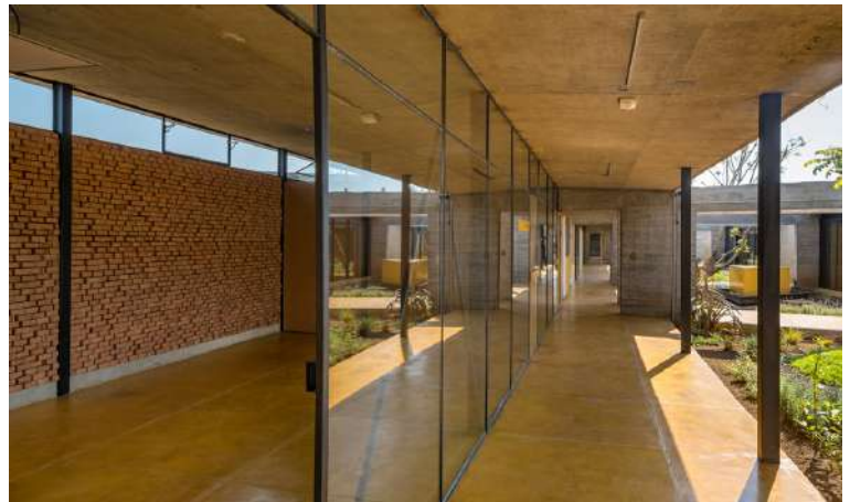
Imagen 13. Área de oficinas administrativas
