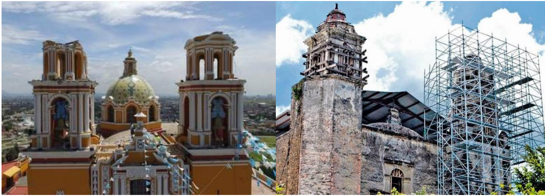
Figura I-2. Campanarios dañados en templos en sismo 2017. a) Santuario del Señor de la Misericordia y b) Exconvento de la Natividad. Figura obtenida en: a) La Jornada , 2017, en https://www.jornada.com.mx/2017/09/26/fotos/036n1est-1.jpg y b) El Sol De Cuautla , 2018, en https://www.elsoldecuautla.com.mx/local/callaron-las-campanas-en-tepoztlan-tras-el-19s-2016567.html .
