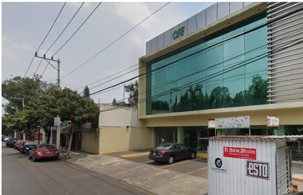
Figura 11: Estructura eléctrica al exterior del inmueble.
