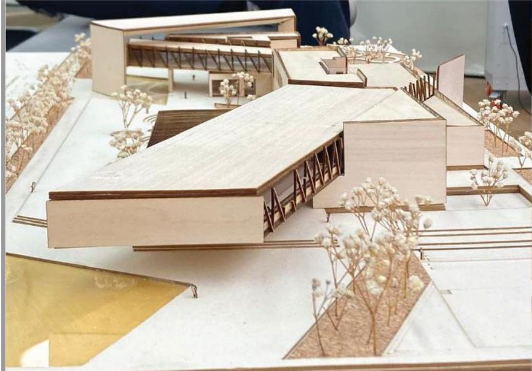
Fig. 5.20 Maqueta del proyecto en donde muestran los voladizos librados con el sistema de vector activo.
