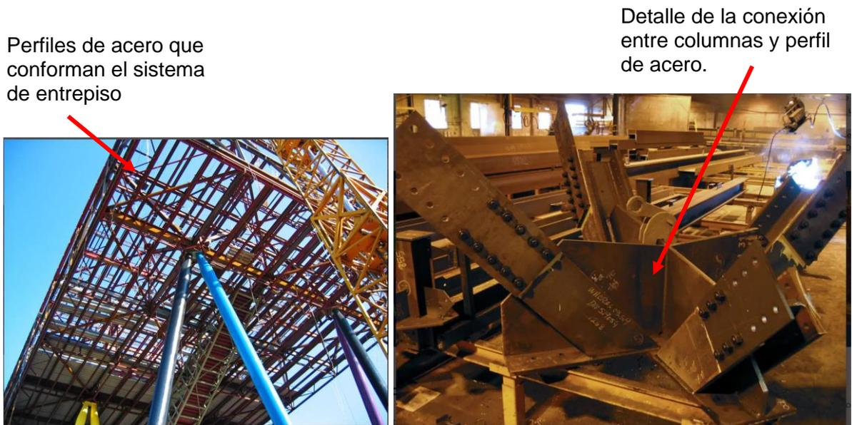
Fig. 5.28 Identificación de los perfiles de acero y detalle constructivo de las columnas. *Nota.* Adaptado de <https://www.waltersgroupinc.com/project/ocad/>
