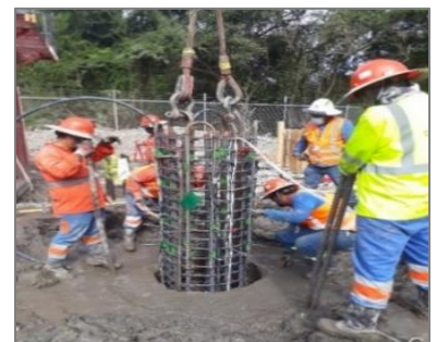
(i) Finalización de instalación de tubería
