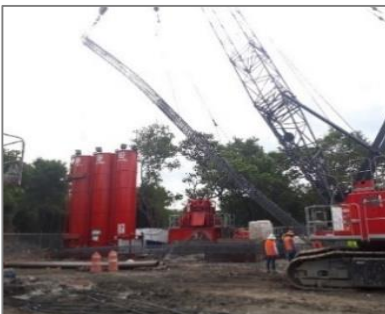
(g) Izaje del armado de la pila
