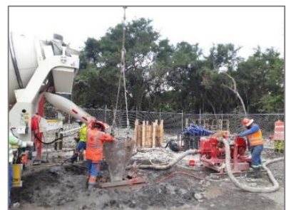
(l) Colado de la pila
