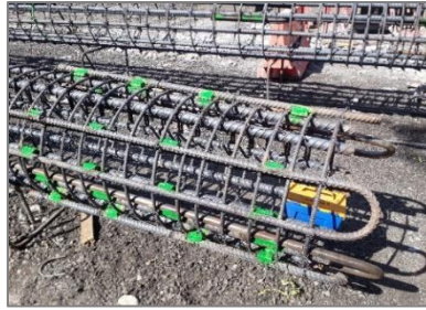
(b) Armado de la pila de reacción
