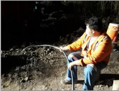
(d) Purgado de la tubería
