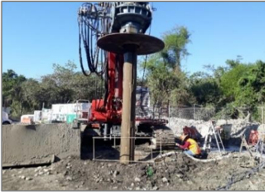
(a) Perforación de la pila de reacción
