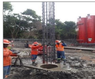
(h) Colocación del armado
