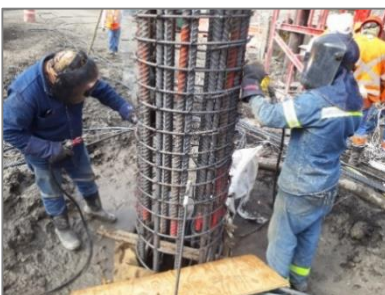
(j) Soldadura del armado
