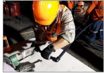
(c) Uniones de mangueras por termofusión
