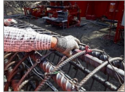
(f) Fijación de los sensores PT-100
