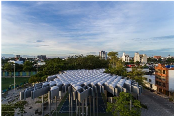
70.- Fotografía aérea de la cubierta
