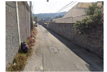
28.- Vista Sur de la calle Ahualapa 2
