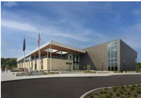
Figura 3.18 Exterior del Centro de Bienestar West Lafayette.
