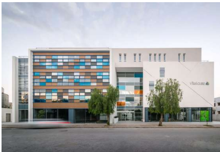
Figura 3.16 fachada principal del Consultorio médico Vital Cube.
