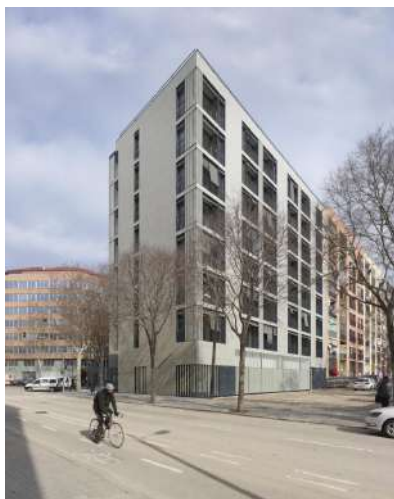
Figura 3.9 Exterior del Edificio Mixto de Viviendas y Alojamientos.
