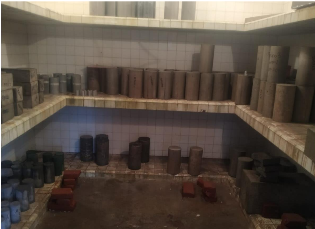
Figura 3.8 Cámara de curado
