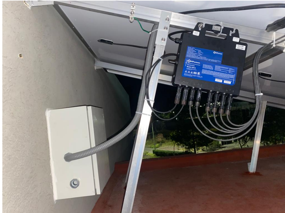
Figura 9: Microinversor QSI1A y caja de conexiones.
