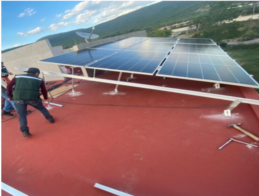
Figura 10: Instalación de estructura de aluminio anodizado y montaje de paneles.
