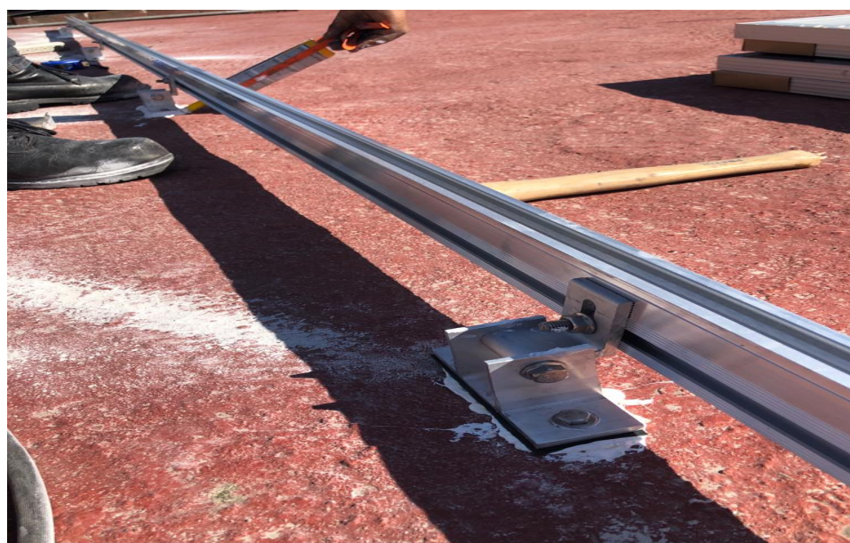
Figura 12: Riel sujeto a L-Food de aluminio anodizado.
