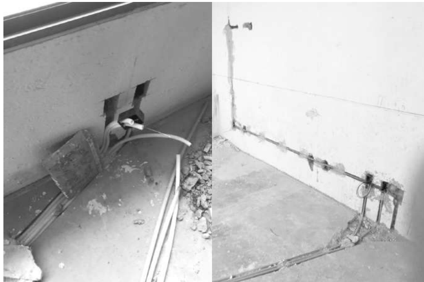
Figuras 24 y 25: Rasurado y cableado eléctrico
