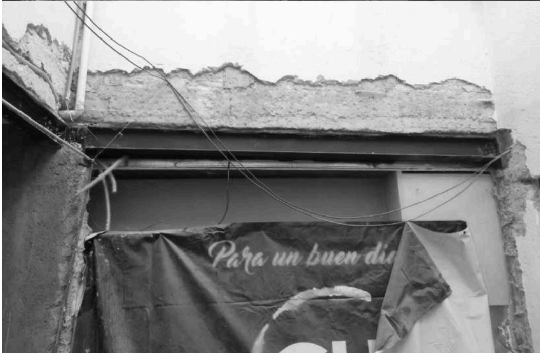
Figura 47 y 48 : Demolición e instigación de traves metálicas
