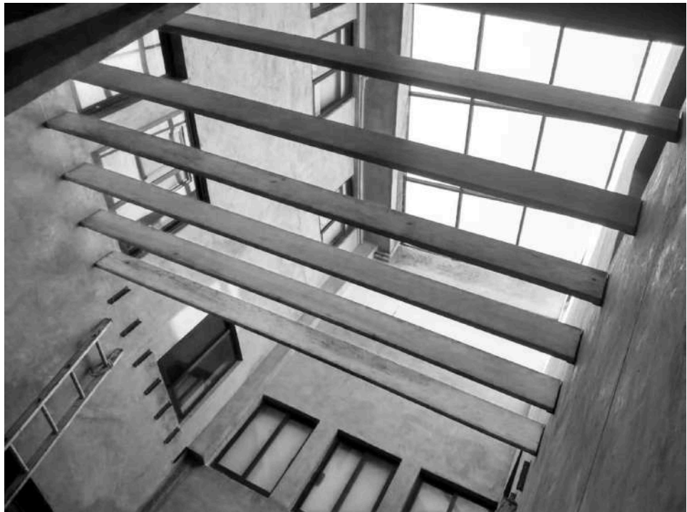
Figura 51: Colocación de vigas de madera
