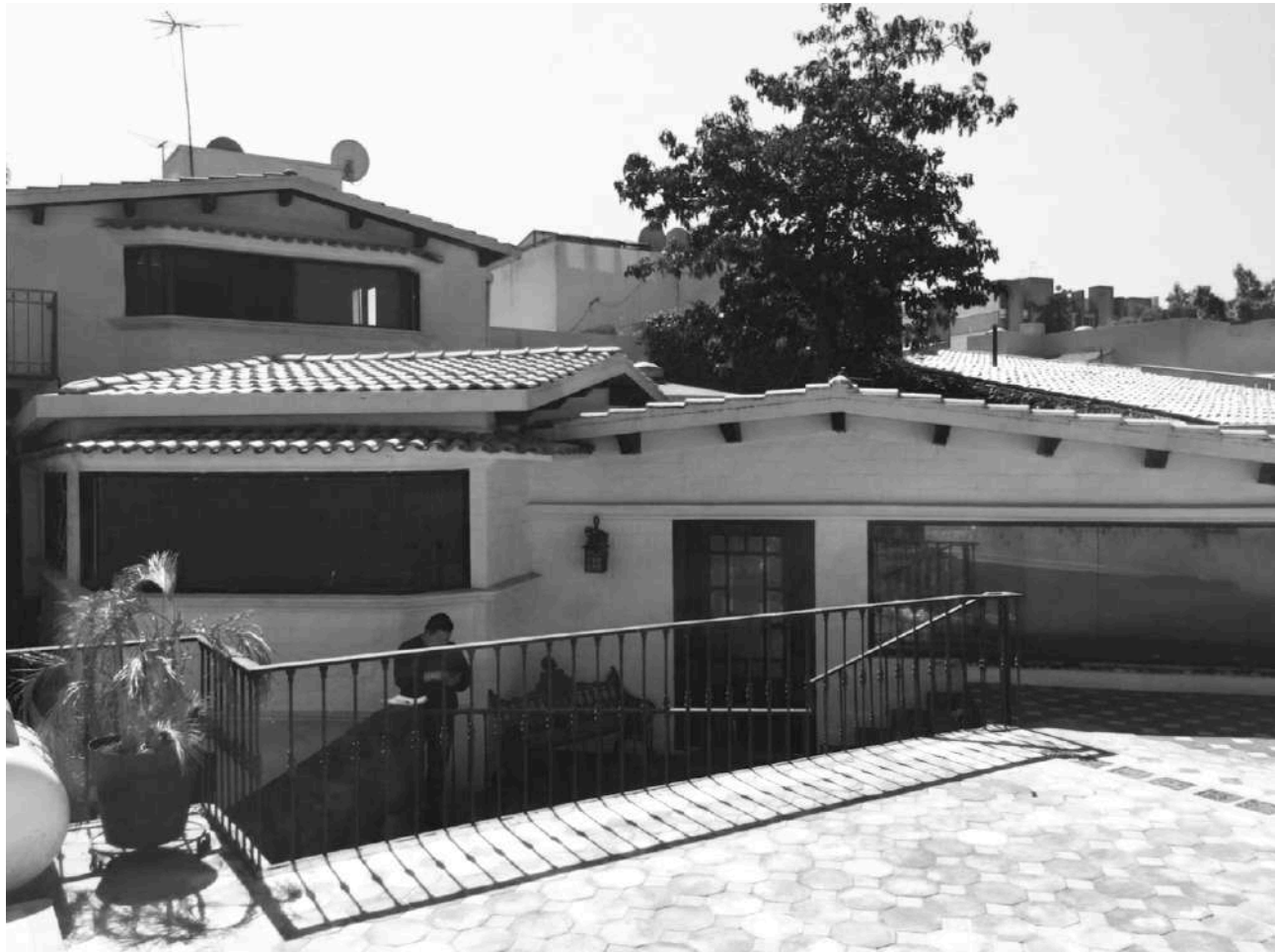
Figura 3: Fachada interior antes de remodelación
