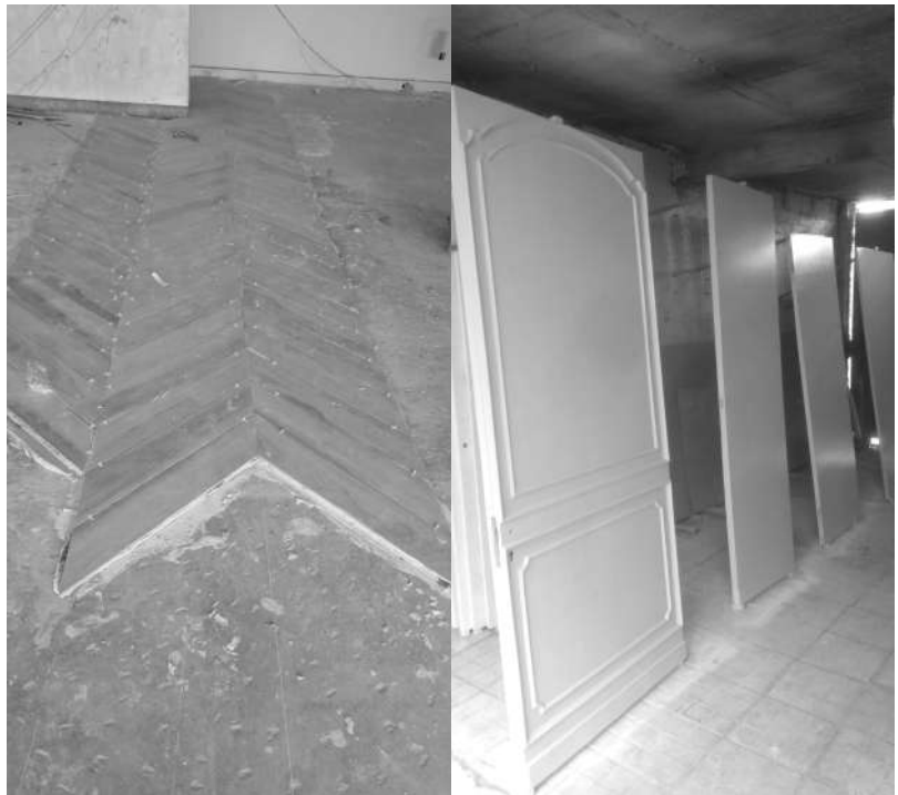
Figura 67: Colocación de piso
