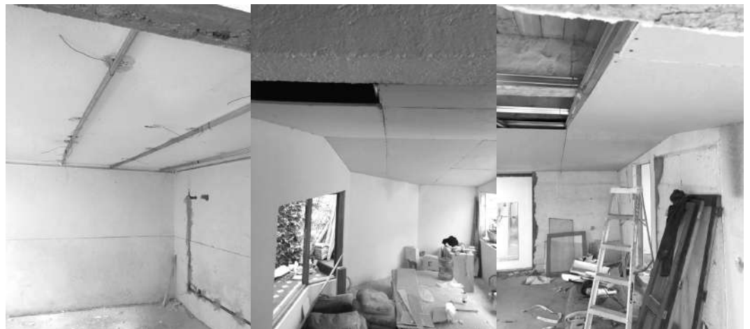
Figura 30-32: Colocación de plafones
