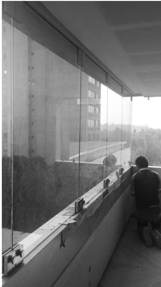
Figura 71 : Colocación de cancel
