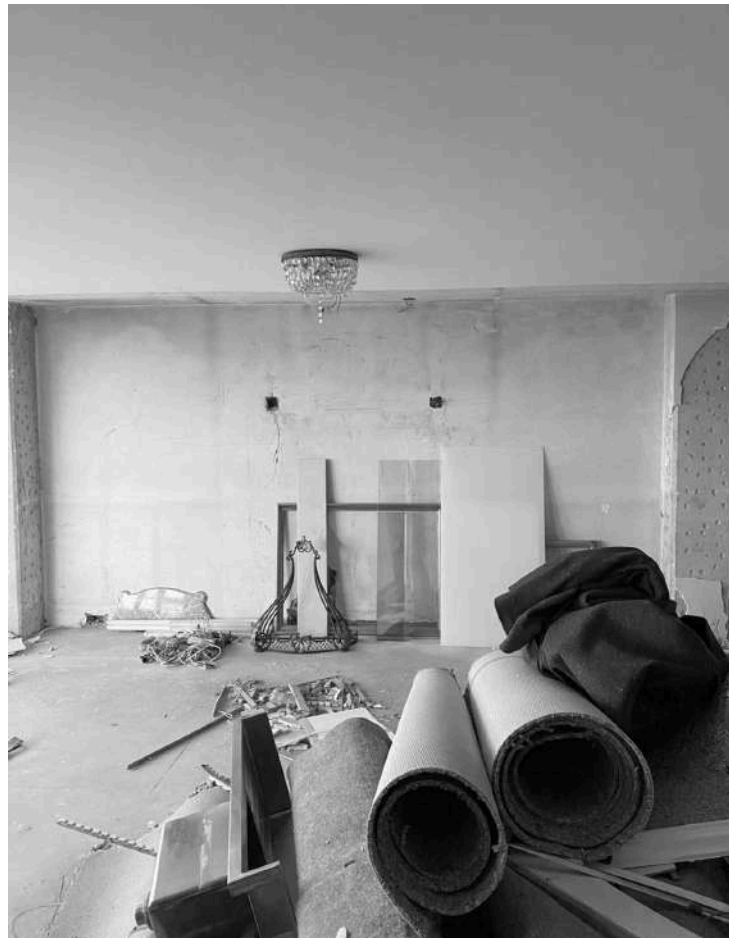
Figura 63: Desmantelamiento de la estancia
