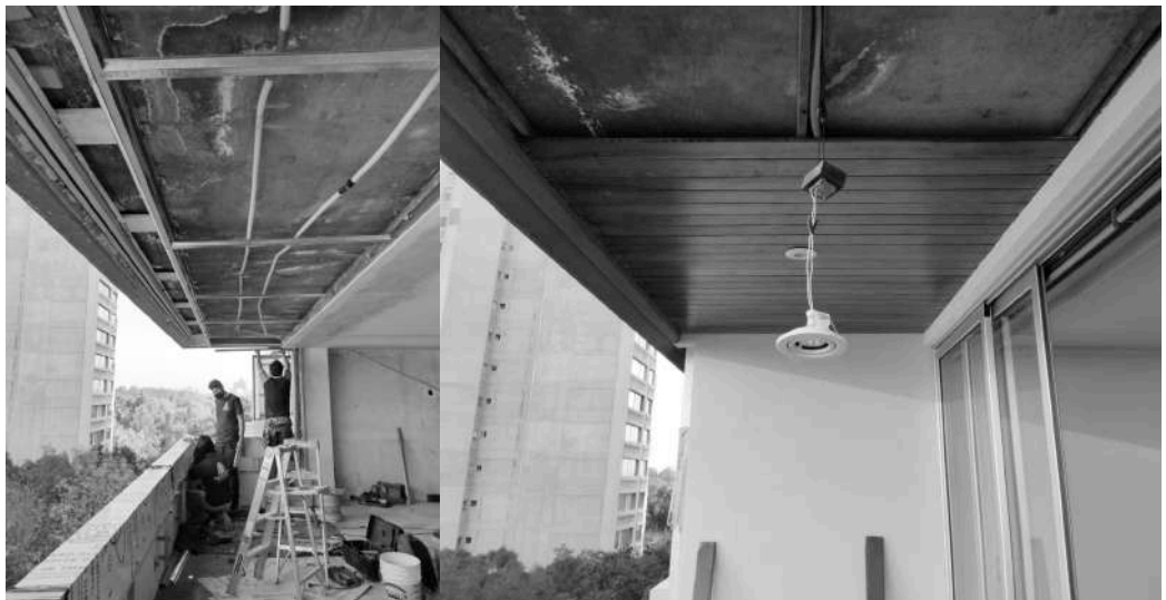
Figuras 64 y 65: Colocación de instalaciones eléctricas en terraza
