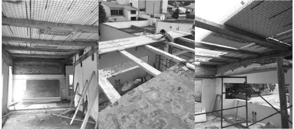
Figura 28-29: Construcción de losas con panel estructural
