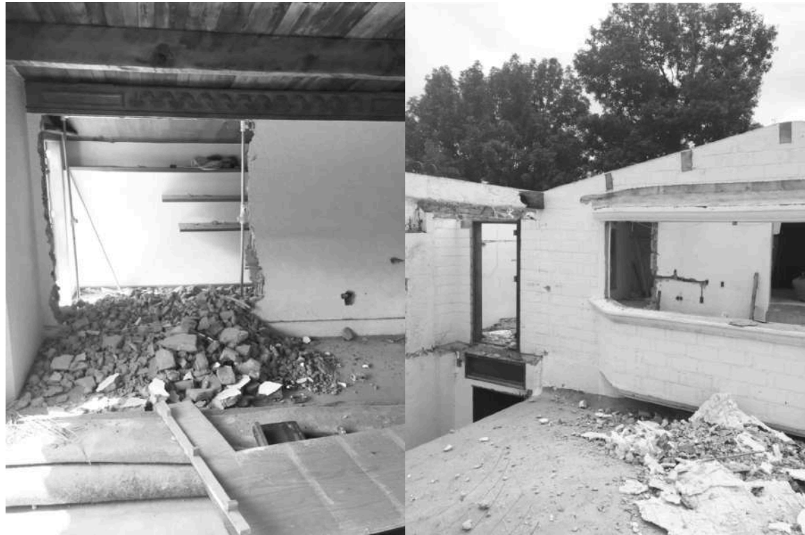
Figuras 22 y 23 : Desmantelamiento general
