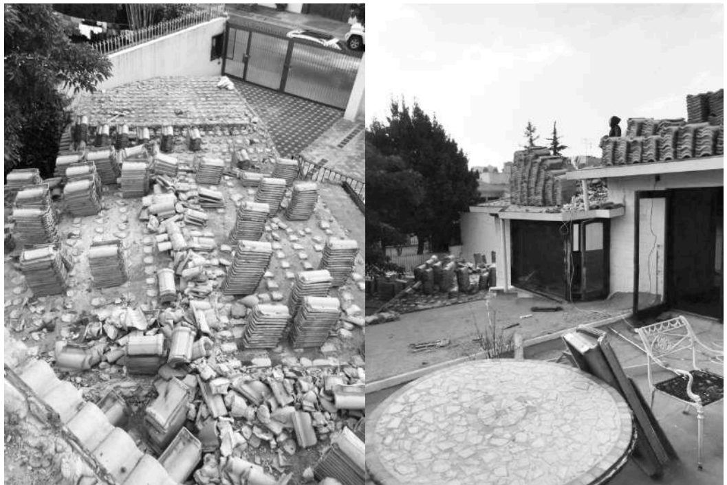
Figura 21: Retiro de teja
