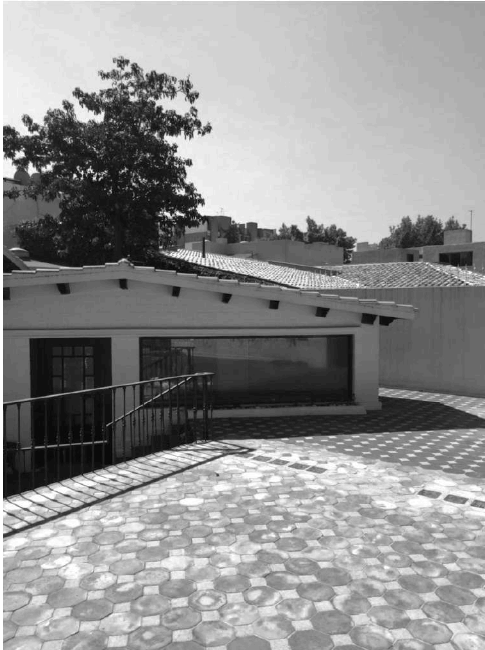
Figura 4: Fachada interior antes de remodelación
