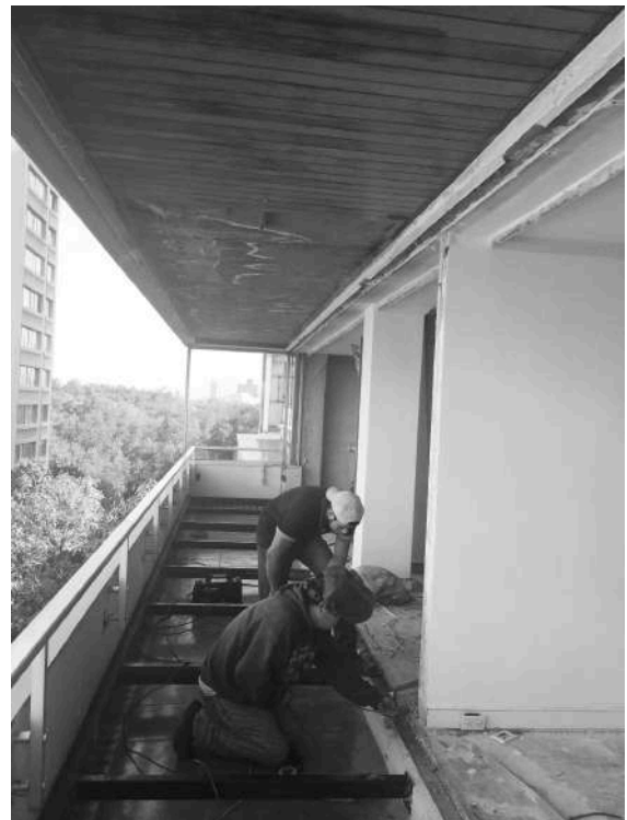
Figura 69: Colocación de estructura en terraza.
