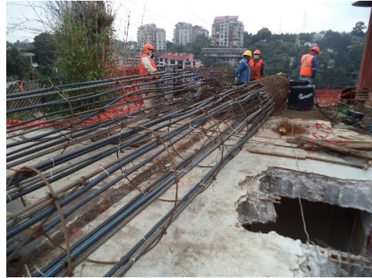
Figura I.10 Parte inferior de pilas de energía.
