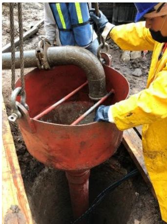
Figura I.35 Colado de pila de energía
