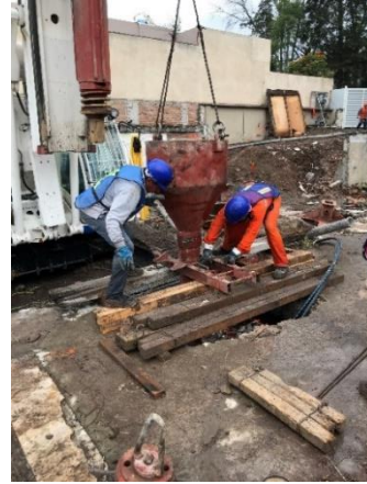
Figura I.40 Retiro de las tuberías para colado
