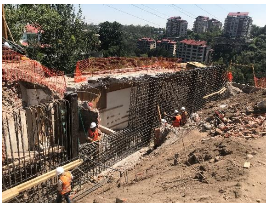
Figura I.49 Habilitado de muros con acero
