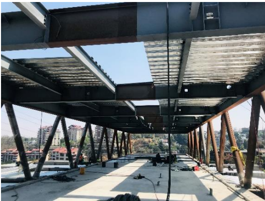
Figura I.71 Vista frontal de la techumbre sobre la losa de concreto
