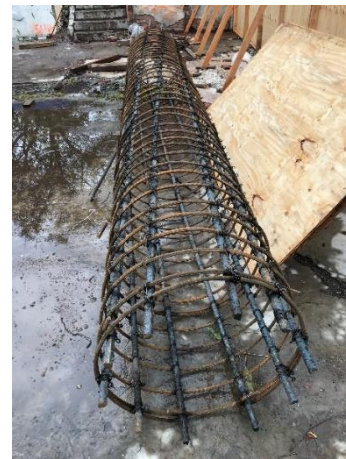
Figura I.18 Pila de energía.
