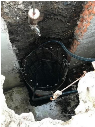
Figura I.41 Vista de una pila previo a su colado
