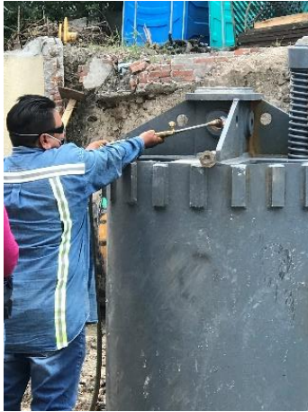
Figura I.3 Detalle de la broca de perforación.
