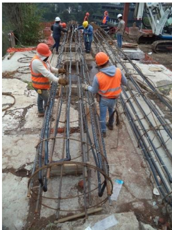
Figura I.7 Armado de la pila de energía.
