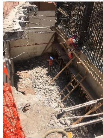
Figura I.54 Habilitado de muros
