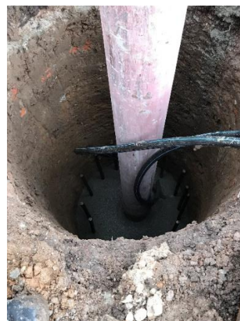
Figura I.38 Colado finalizado de pila de energía
