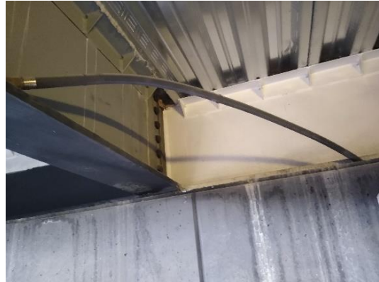
Figura I.82 Vista de manguera sellada saliendo del muro de concreto
