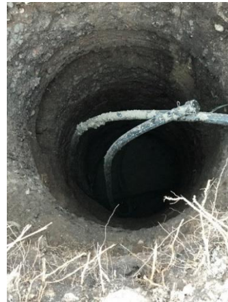
Figura I.42 Mangueras saliendo de la pila de energía
