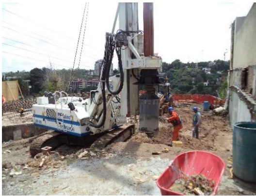
Figura I.5 Posicionamiento de la maquinaria de perforación en uno de los puntos donde se alojará una pila.
