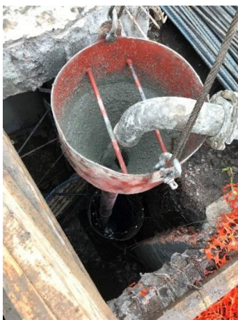
Figura I.37 Colado de pila de energía
