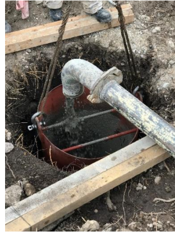
Figura I.34 Inicio del colado de la pila de energía
