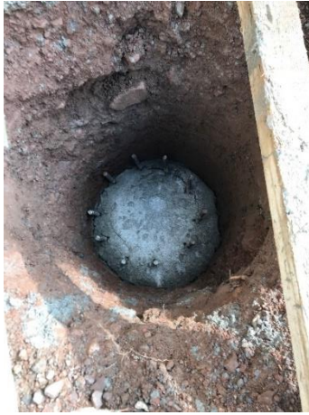
Figura I.45 Pila convencional colada y con sus mangueras sobresaliendo del concreto
