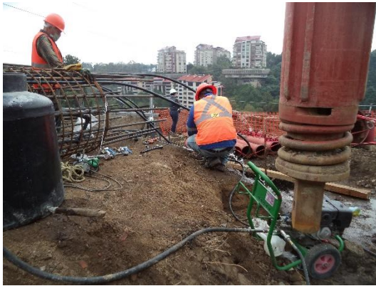
Figura I.21 Inicio de las pruebas de presión y purgado de las mangueras
