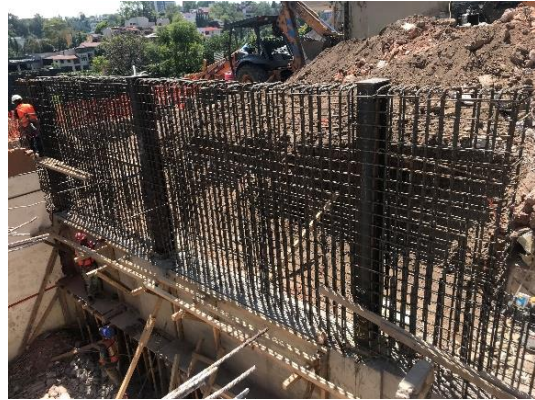
Figura I.52 Habilitado de muros
