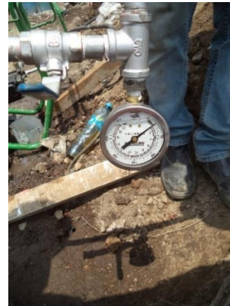
Figura I.22 Manómetro en operación durante la ejecución de la prueba de purgado
