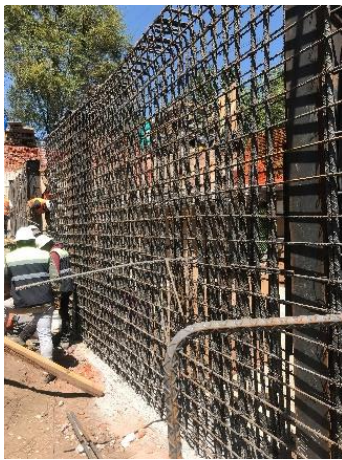
Figura I.53 Habilitado de muros
