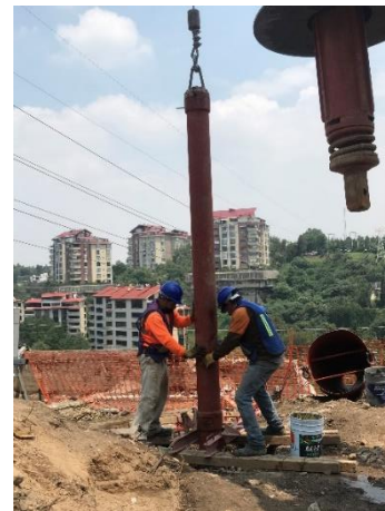
Figura I.30 Preparando equipo para el colado de la pila
