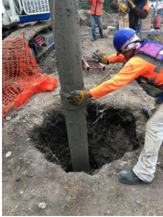
Figura I.39 Retiro de las tuberías para colado
