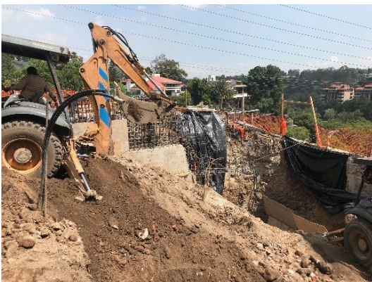
Figura I.55 Habilitado de muros
