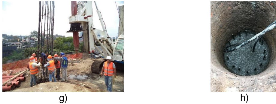
Figura 4.2 Proceso constructivo de armado de las pilas de energía: a) armado de la pila de energía, b) colocación de tuberías con termofusión, d) prueba de presión en tuberías, e) manómetro empleado en las pruebas de presión, e) perforación en el suelo, f) hizaje del armado, g) colocación dentro de la perforación y h) colado de pila.
