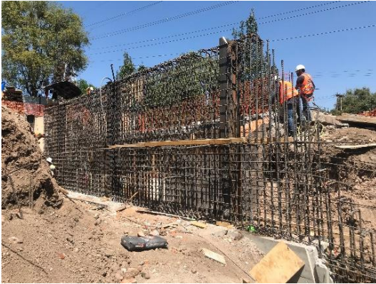
Figura I.51 Habilitado de muros
