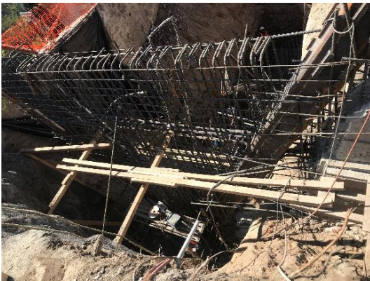
Figura I.65 Armado de muro sobre estructura V
