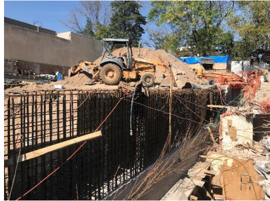
Figura I.64 Armado de muros
