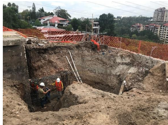
Figura I.48 Habilitado de trabe y dado
