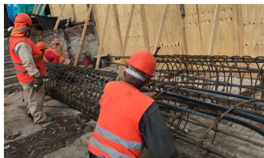
Figura I.20 Habilitado de acero en pilas.
