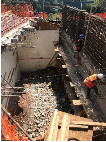
Figura I.57 Habilitado de muros
