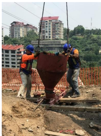
Figura I.31 Colocación del embudo para recibir concreto
