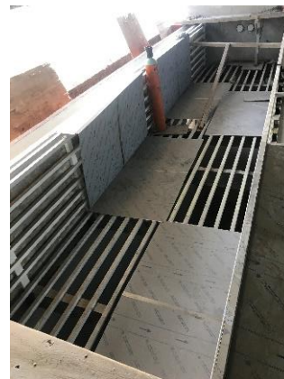
Figura I.80 Vista de cisterna que contiene mangueras en si interior.
