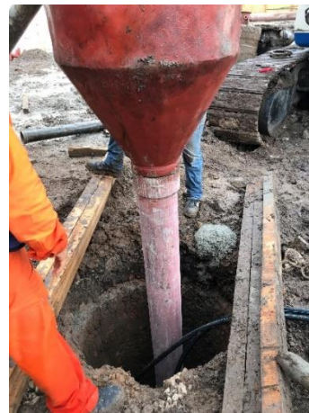
Figura I.36 Colado de pila de energía
