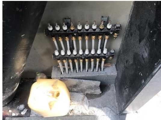
Figura I.74 Zona de Conexión entre el circuito primario y secundario
