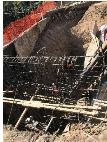
Figura I.66 Armado de muro sobre estructura V
