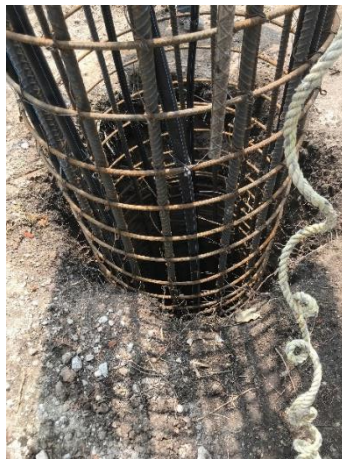
Figura I.29 Detalle del armado de la pila de energía
