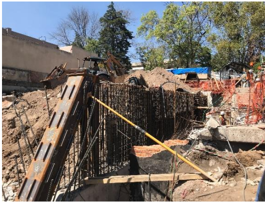
Figura I.59 Unión de armado de acero con perfiles
