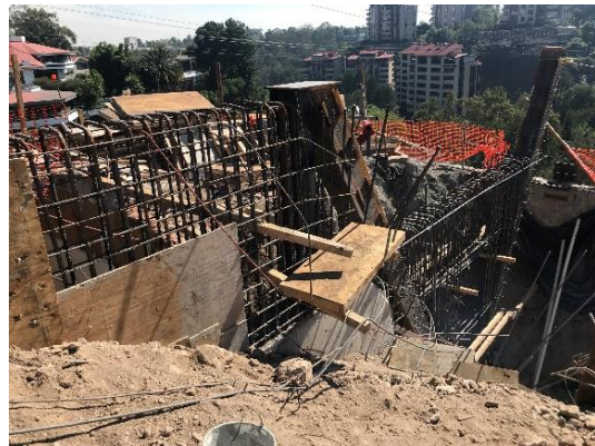
Figura I.62 Estructura metálica en V lado sur
