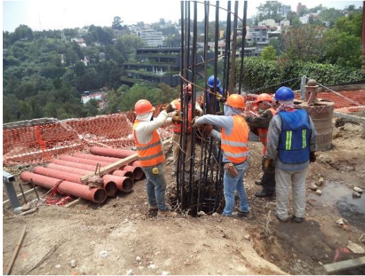
Figura I.27 Descenso del armado de la pila de energía dentro del pozo
