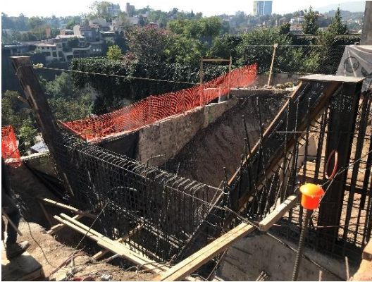
Figura I.63 Estructura metálica en V lado sur
