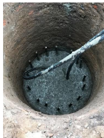
Figura I.44 Pila de energía colada y con sus mangueras sobresaliendo del concreto
