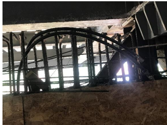
Figura I.68 Mangueras de polietileno sobresaliendo del muro de concreto
