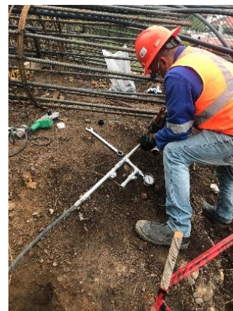
Figura I.24 Ejecución de la prueba de purgado
