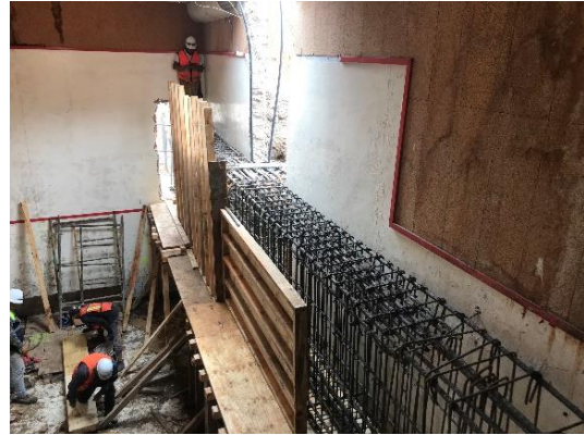
Figura I.46 Habilitado y armado de elementos de unión entre cabezales de pilas
