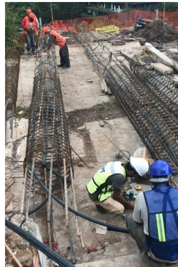
Figura I.14 Pegado de las tuberías mediante termofusión.
