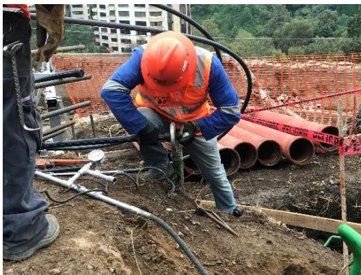
Figura I.23 Manómetro en operación durante la ejecución de la prueba de purgado
