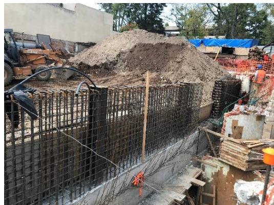
Figura I.56 Habilitado de muros
