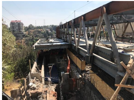
Figura I.72 Vista lateral lado norte de la techumbre sobre la losa de concreto
