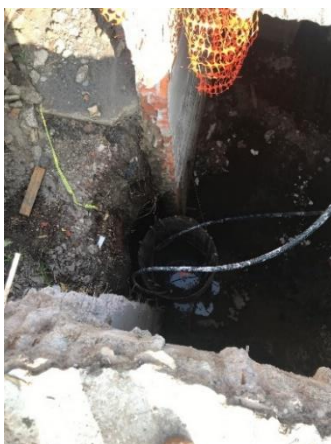
Figura I.43 Vista de una pila previo a su colado
