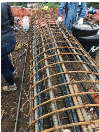
Figura I.19 Detalle de los estribos en espiral y dentro de ellos las mangueras.
