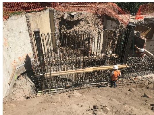
Figura I.50 Habilitado de muros
