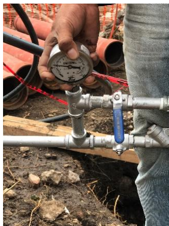
Figura I.25 Equipo durante pruebas de purgado y presión.
