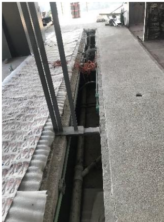
Figura I.77 Vista de la losa de concreto (piso radiante)
