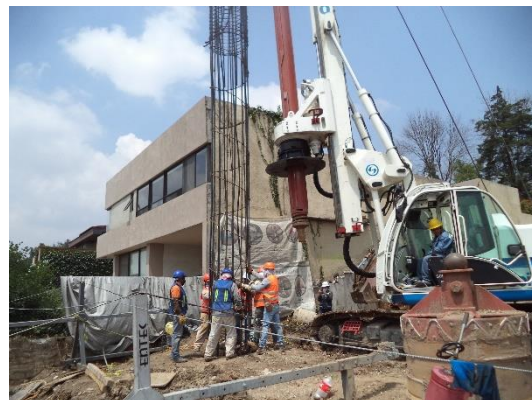
Figura I.26 Izaje y montaje del armado de una pila de energía
