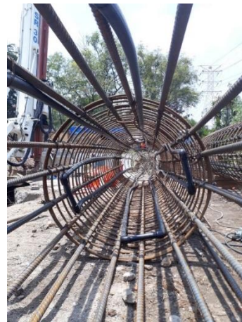
Figura I.8 Habilitado de los bucles de mangueras de polietileno.
