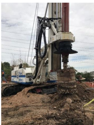
Figura I.1 Maquinaria realizando labores de perforación en sitio.
