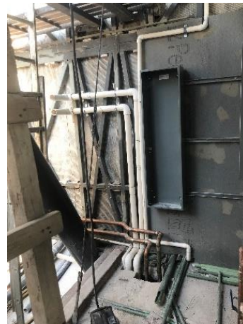
Figura I.78 Zona de Conexión entre el circuito primario y secundario
