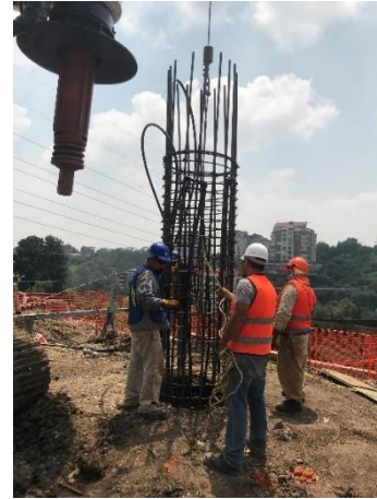
Figura I.28 Descenso del armado de la pila de energía dentro del pozo
