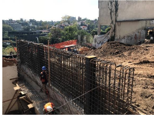
Figura I.58 Habilitado de muros
