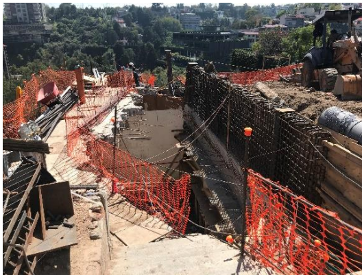
Figura I.61 Vista de los muros habilitados
