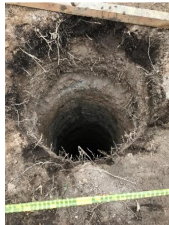
Figura I.6 pozo excavado para albergar una pila de energía.
