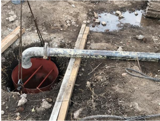
Figura I.33 Tubería para el colado lista
