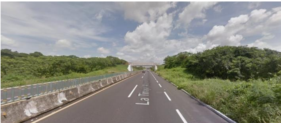
Imagen 8. Carretera Cordoba–Minatitlán (s.f.). Recuperado de https://goo.gl/maps/VY9hiUPhxGkoFMre8
