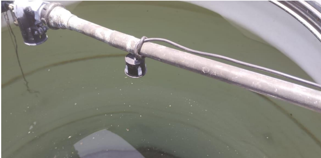
Ilustración 3.26 Colocación del sensor ultrasónico.
