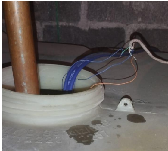
Ilustración 4.6 Electrodo en un depósito de mil litros de agua.
