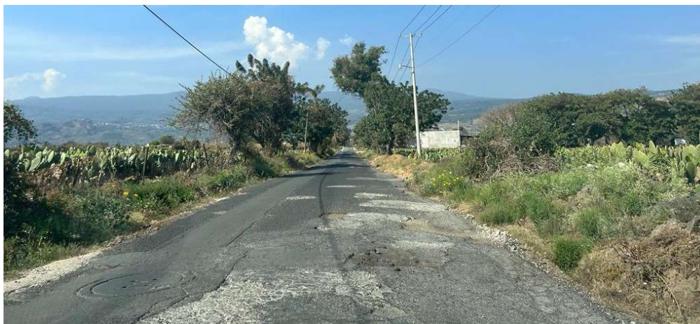
Ilustración 17. Alternativa usada en carreteras de Morelos que no cuentan con obras de drenaje. Fuente: Propia.
