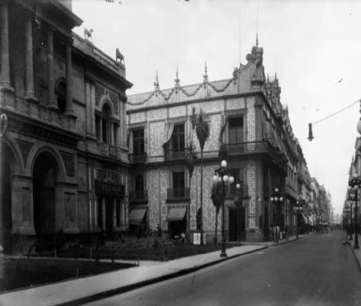
Figura 2.5. La Casa de los Azulejos.
