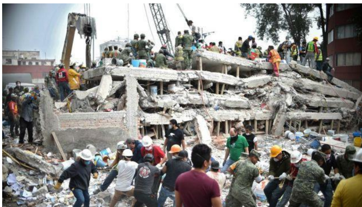
Ilustración 11 Colapso de edificio durante terremoto de 19 de septiembre del 2017 en la CDMX. Fuente BBC Noticias
