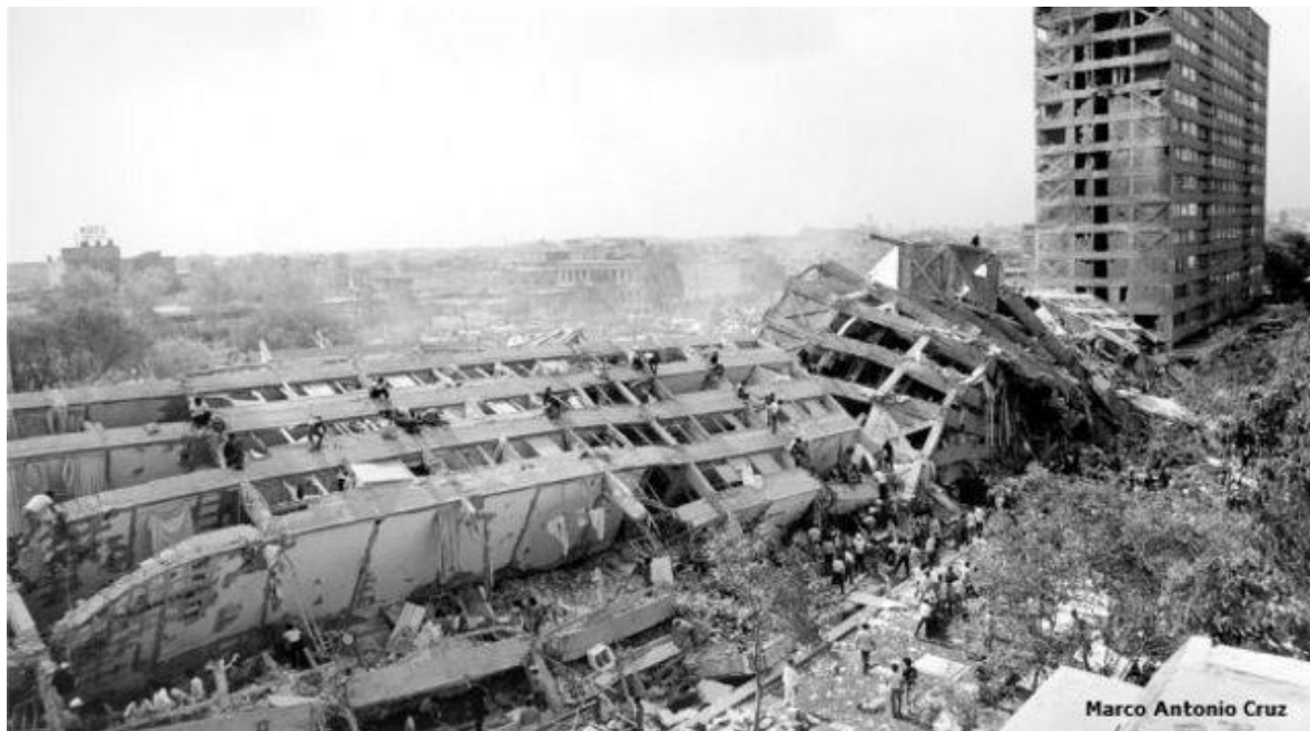
Ilustración 10 Edificio Nuevo León de Tlatelolco. Fuente BBC Noticias
