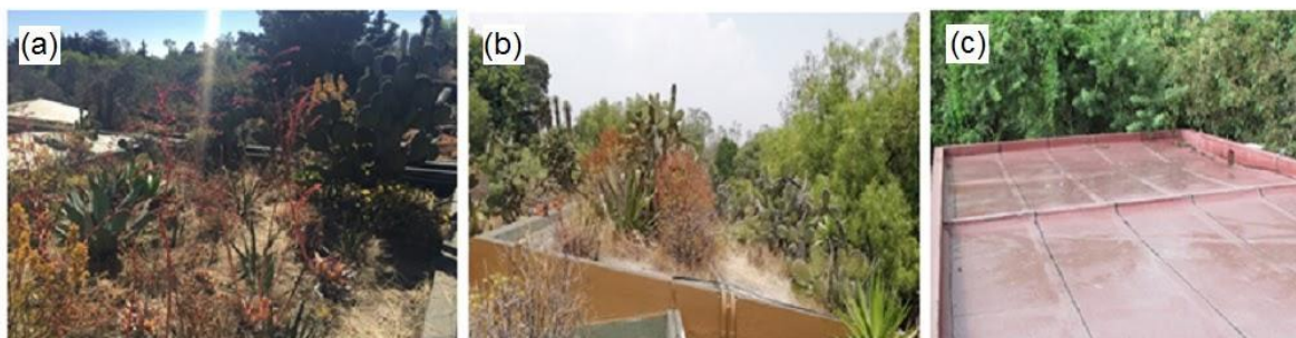
Figura 1. Azoteas verdes extensivas investigadas con (a) una pendiente de 2° (EGRns) y (b) con una pendiente de 14° (EGRws), y (c) la azotea convencional (CR).
