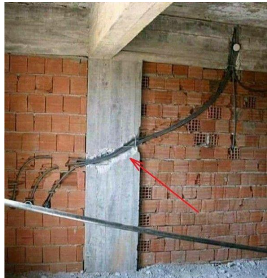
Ilustración 16. Perforación de elementos estructurales, Portal ARQ, 2023.
