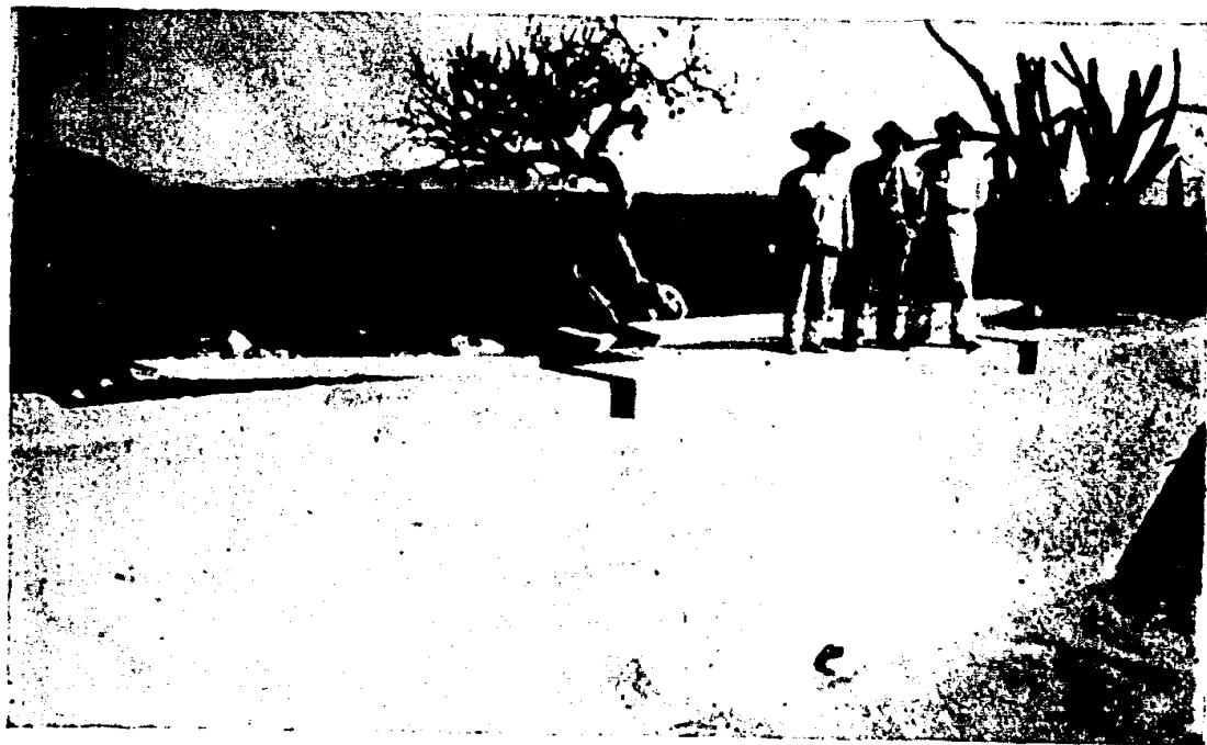
Estanque de aprovisionamiento y distribución para el agua potable y entubada, procedente de los Manantiales de San Miguel Yogovana.
