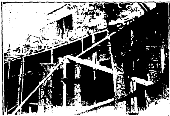
Edificio en construcción del Palacio Municipal y Escuela
