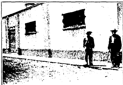
Local destinado a Salón de Sesiones ocupado Provisionalmente por la Escuela.
