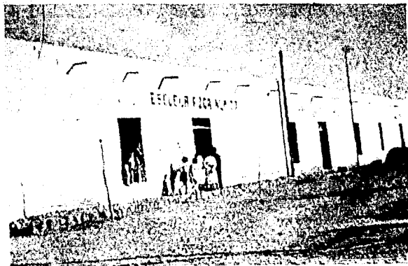
Fot. No. 7. Fachada de la escuela No. 77, correspondiente al barrio de la Plaza
